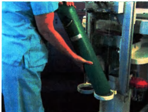
Рисунок 8-25 Держатель для баллона
