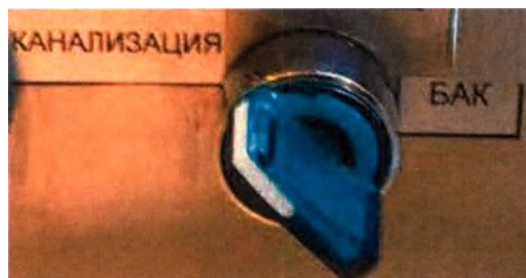
Рисунок 43 – Тумблер «СЛИВ» для выбора режима работы «КАНАЛИЗАЦИЯ» или «БАК» (применимо к вариантам исполнения «Titan Advanced», «Titan Premium», «Titan Ultra»)
