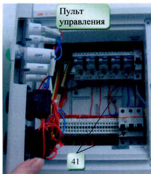
Рисунок 18 – Сетевой щиток
