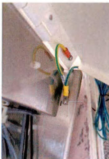
Рисунок 18. Подключение шнура заземления
