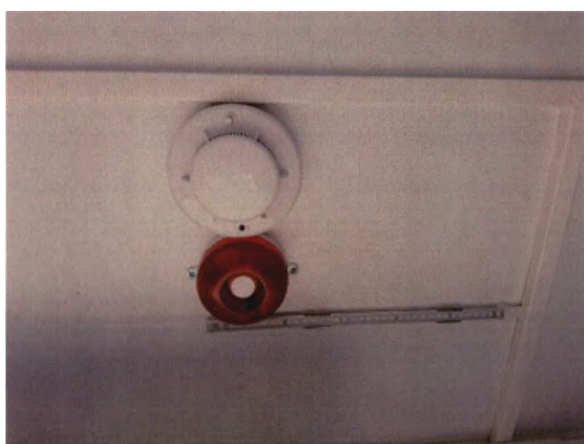
Рисунок 14.1. Извещатель пожарный дымовой и оповещатель охранно-пожарный свето-звуковой.
