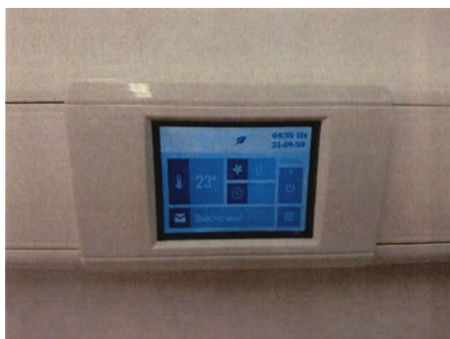
Рисунок 11. Вентиляционная установка. Рисунок 11.1. Пульт управления вентиляционной фильтрующей установкой.
