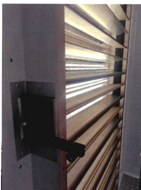
Рисунок 5.1. Жалюзи защитные вентилятора охлаждения
