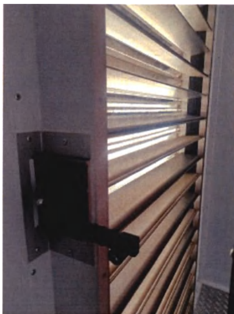
Рисунок 23. Рычаг для открытия защитных жалюзи.
