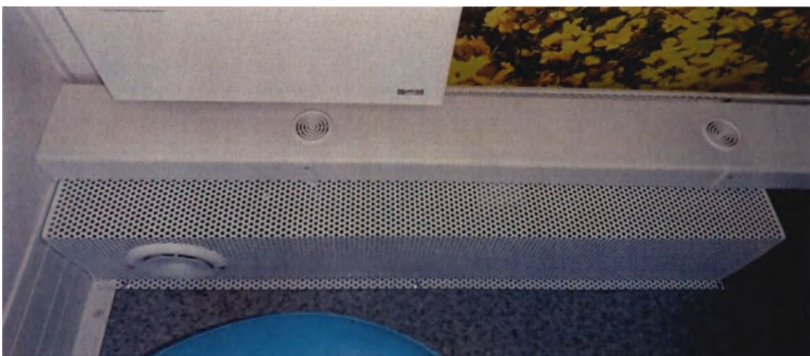
Рисунок 12. Автономный воздушный отопитель.
