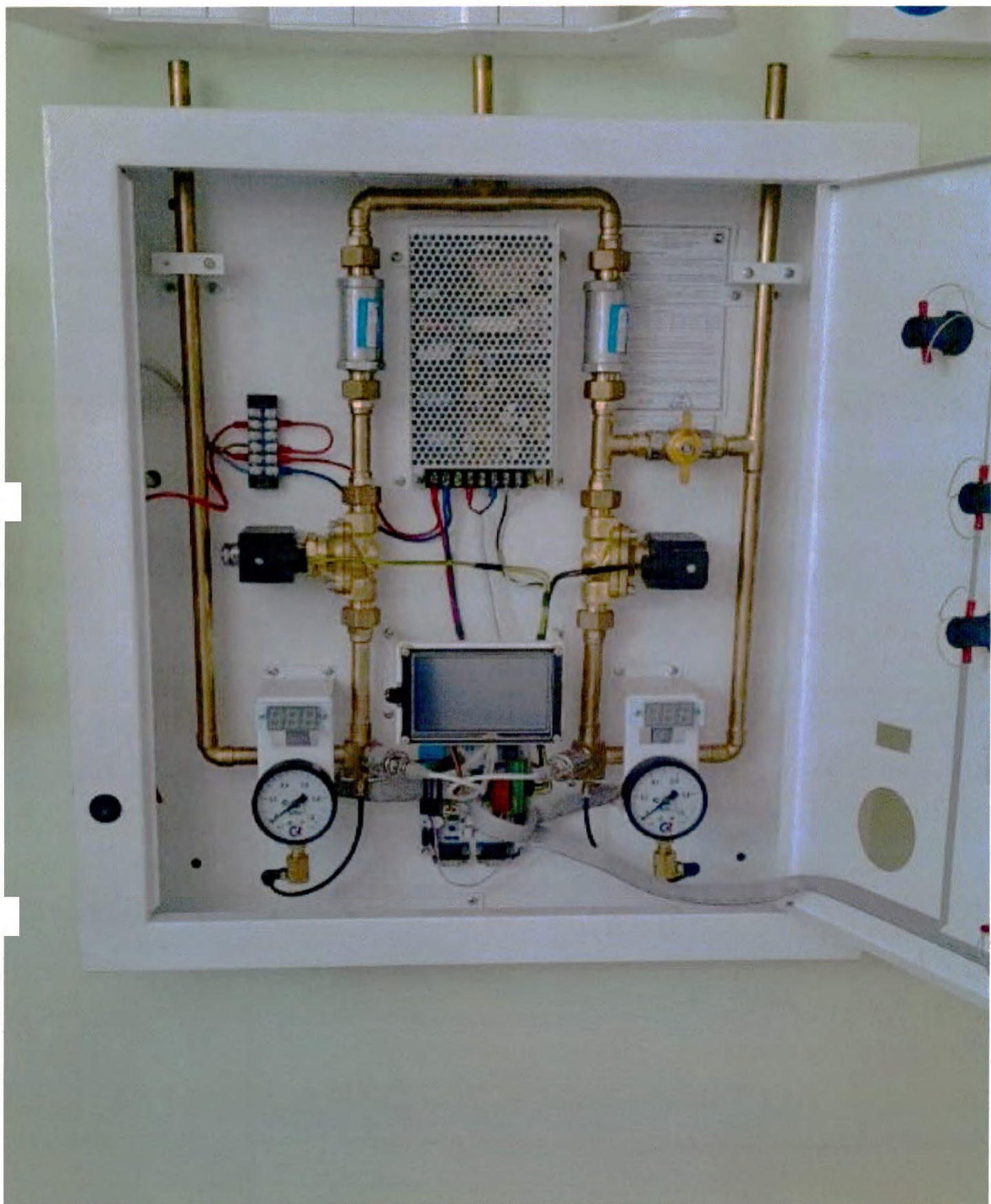
Щит управления для газобаллонной станции медицинского назначения ЩУГБС, производства Корпорация СоТиС (РФ)
