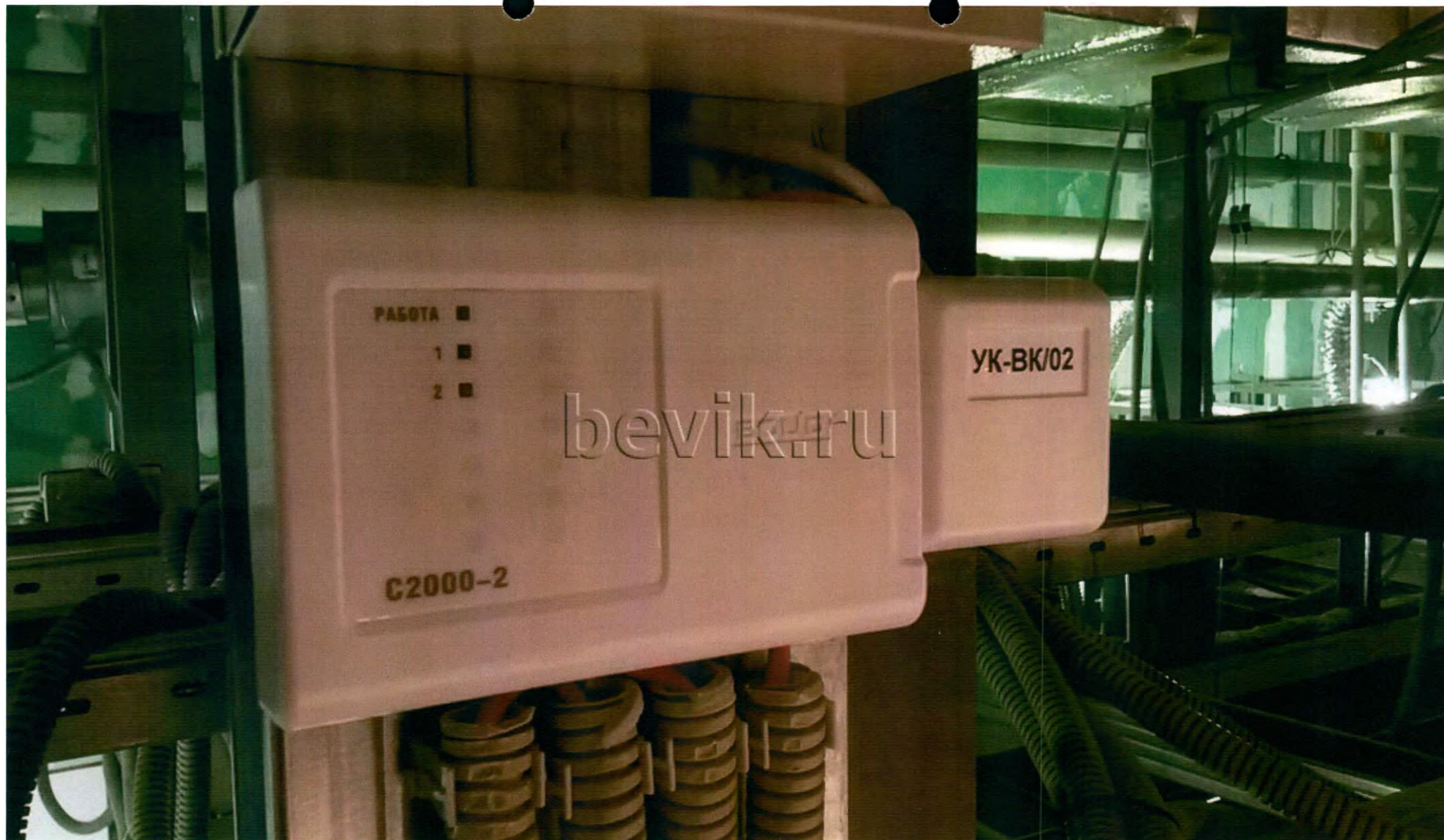
Приборы для системы сигнализации, устройство коммутационное «УК-ВК», производства ОАО «Радий» (РФ)
