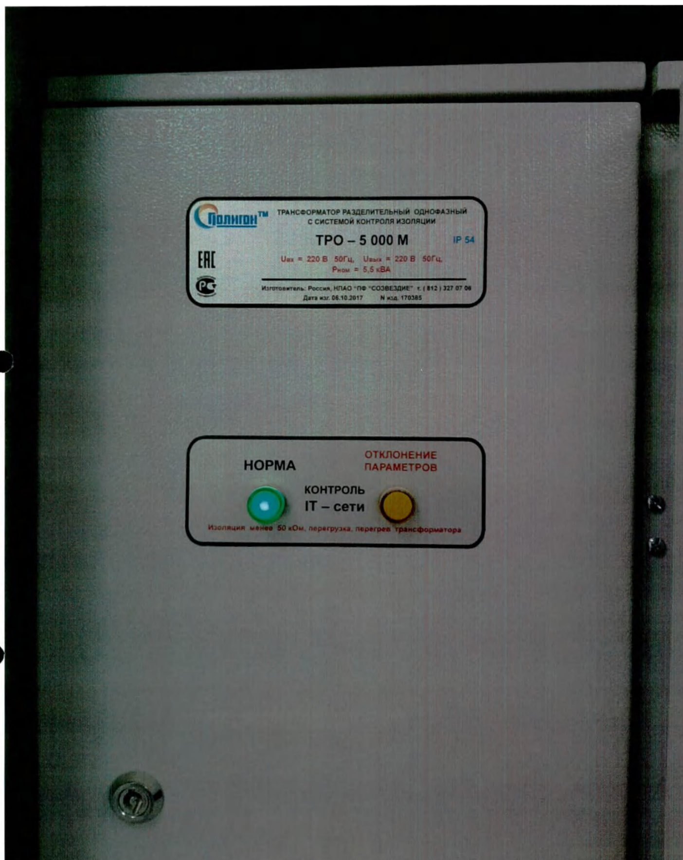
Трансформаторы разделительные, для питания медицинских помещений гр.2, серии ТРО, ТРТ; степень влагозащиты IP54, производства НПАО «ПФ СОЗВЕЗДИЕ», ТУ 3468-019-39441565-2010 (РФ)
