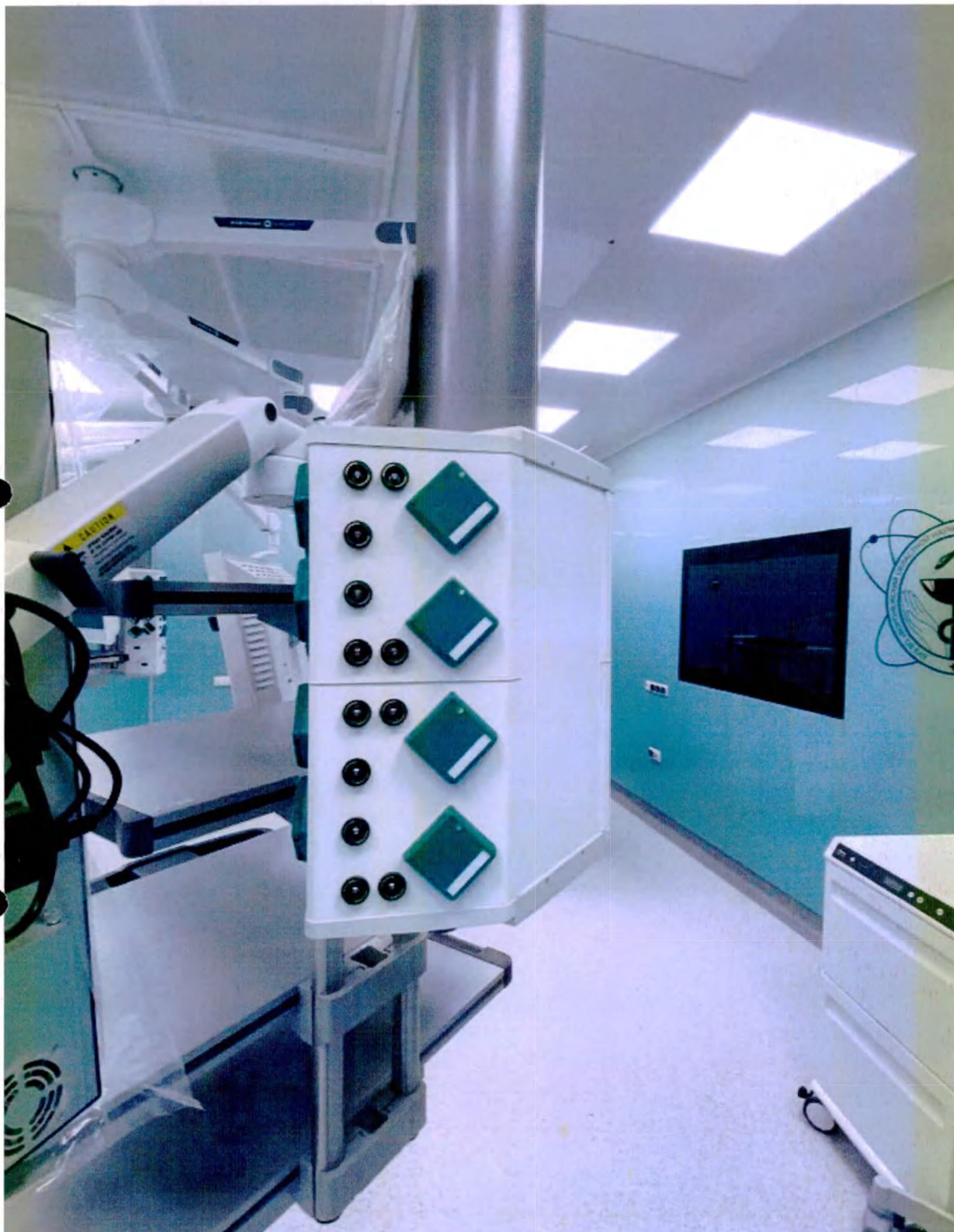
Консоли трансформируемые для подвода медицинского оборудования Independat с принадлежностями, варианты исполнения: Independat30, Independat100, Independat200, Independat300, Independat500, Independat MSU, производства «Гебрюдер Мартин ГмбХ&Ко.КГ» (Германия)
