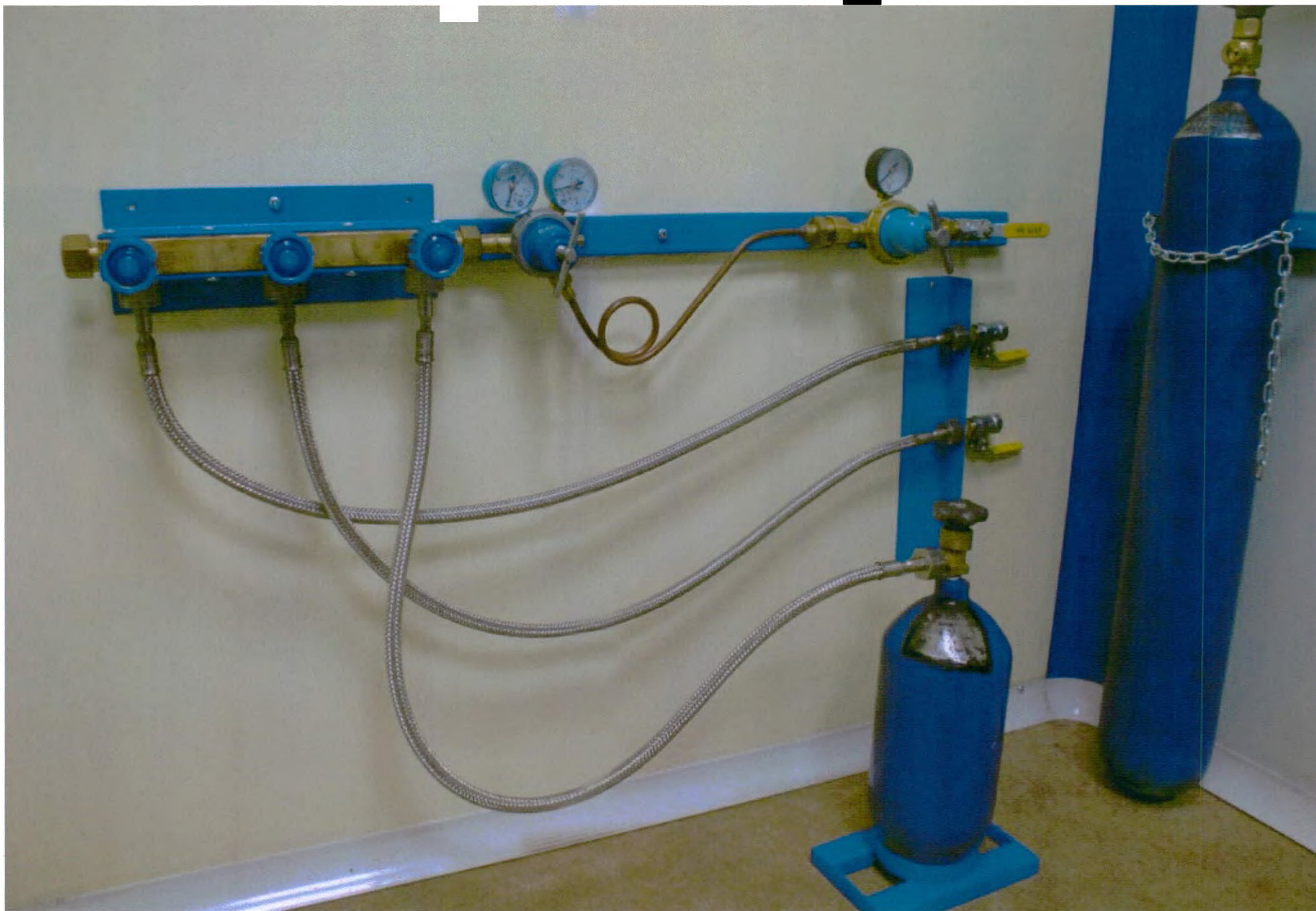
Рампа разрядная газовая медицинского назначения РРГ, производства Корпорация СоТиС (РФ)
