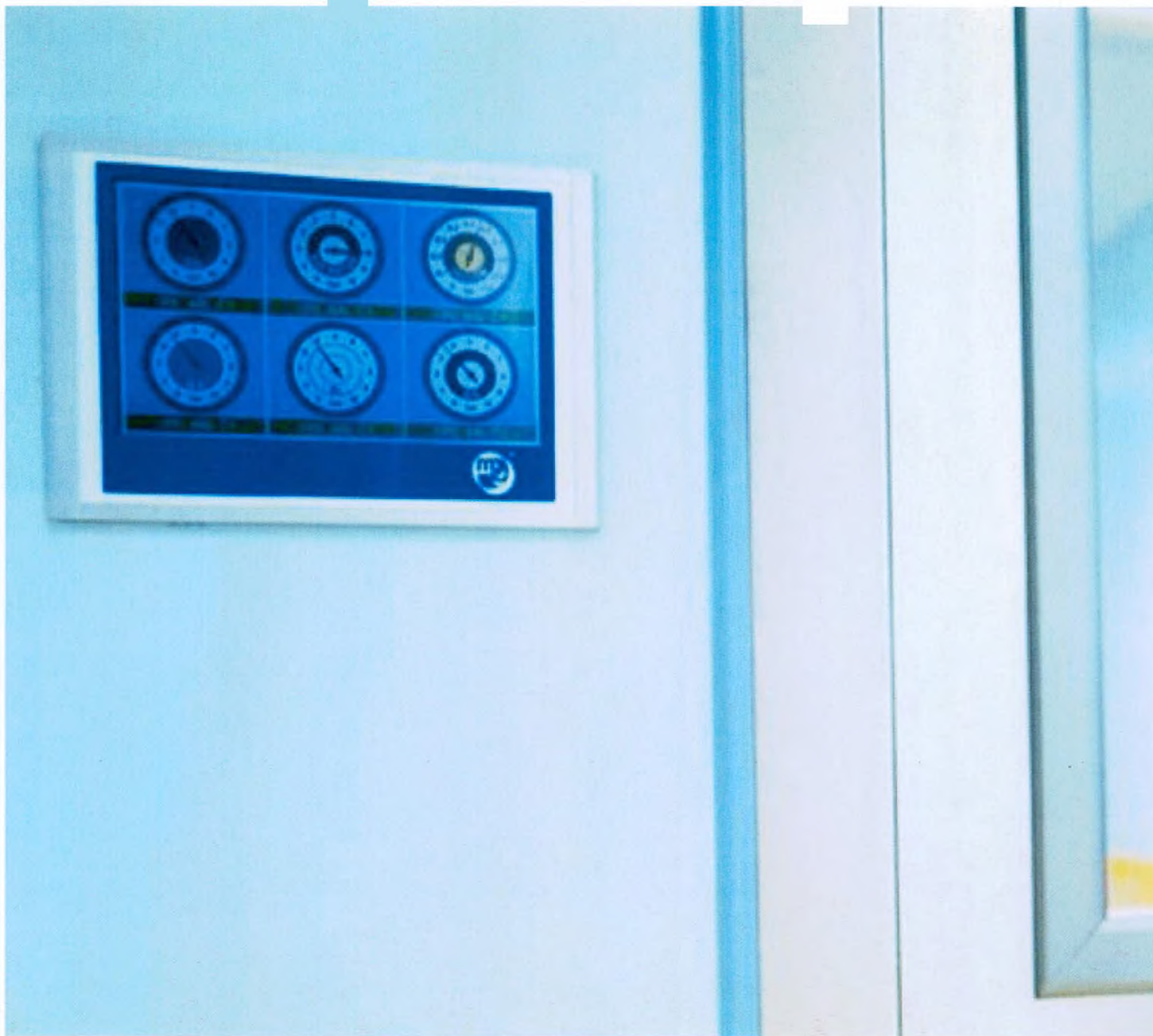
Оборудование для наблюдения и мониторинга давления в распределительных сетях медицинских газов, производства «MZ Liberec, a.s.» (Чехия)
