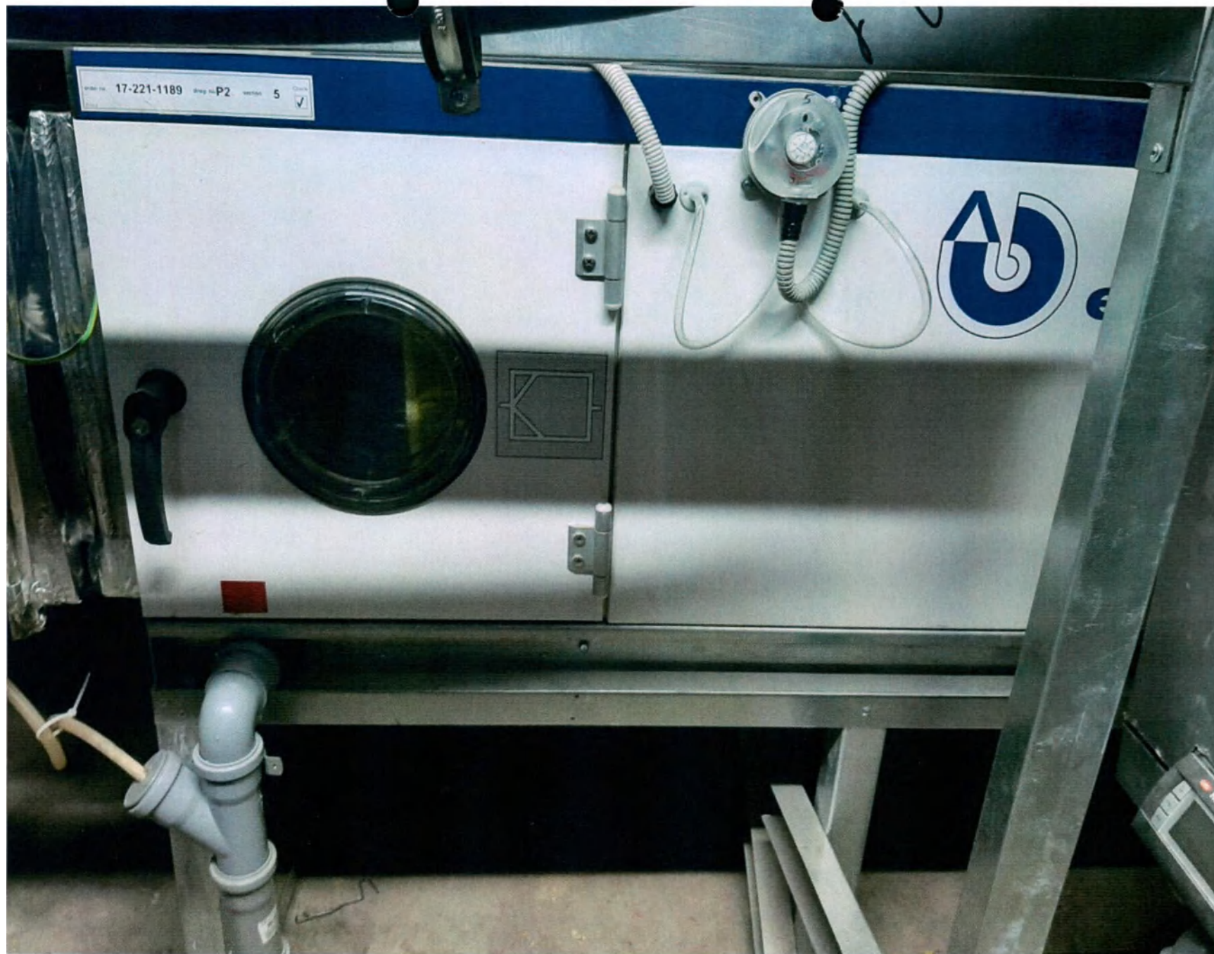
Установка обработки воздуха медицинская EUROCLIMA, модель ZHK 2000, производства «EUROCLIMA SpA» (Италия)
