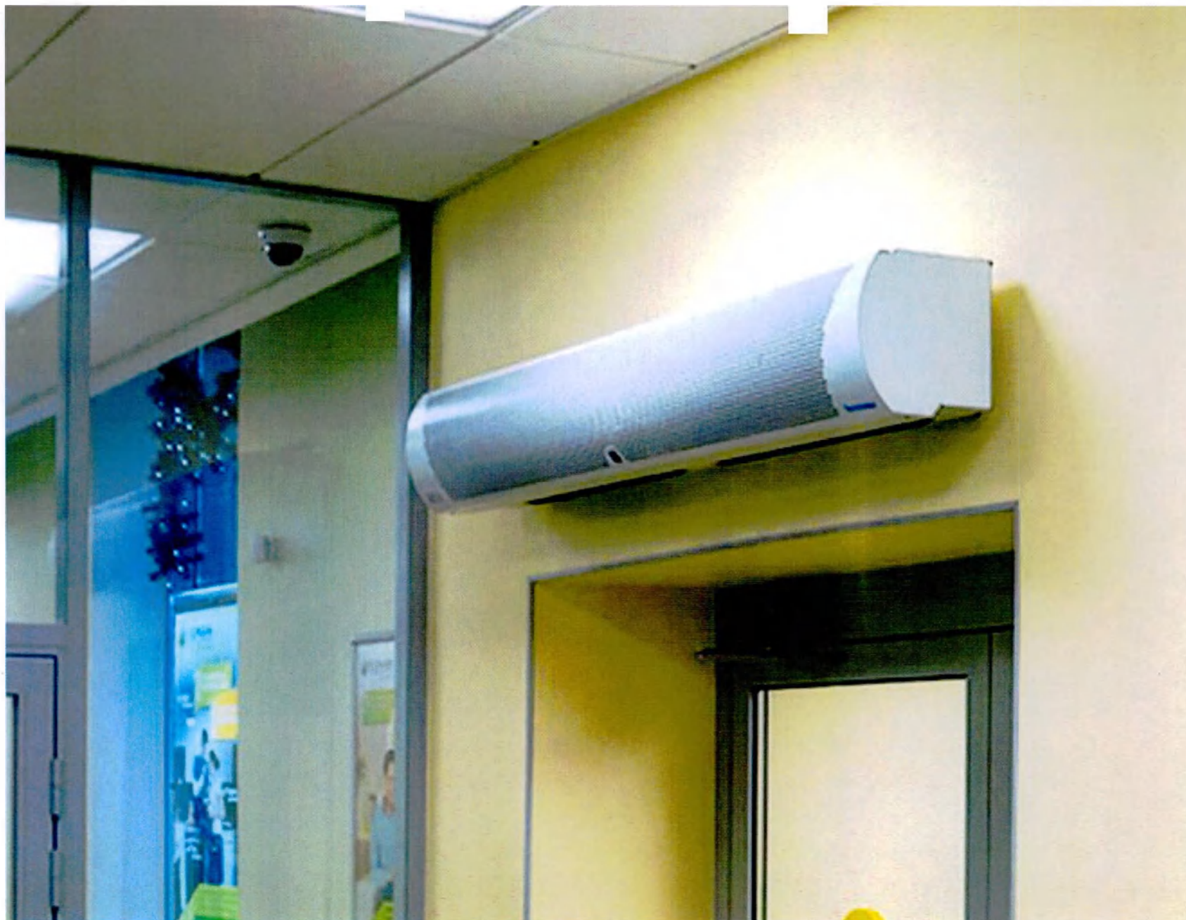
Воздушно-отопительные агрегаты и тепловые завесы «УНИТЕРМ-В» и «ТЗК-ИННОВЕНТ-В», производства ООО «Завод вентиляционного оборудования «Инновент», ТУ 4864-005-56888434-2014 (РФ)
