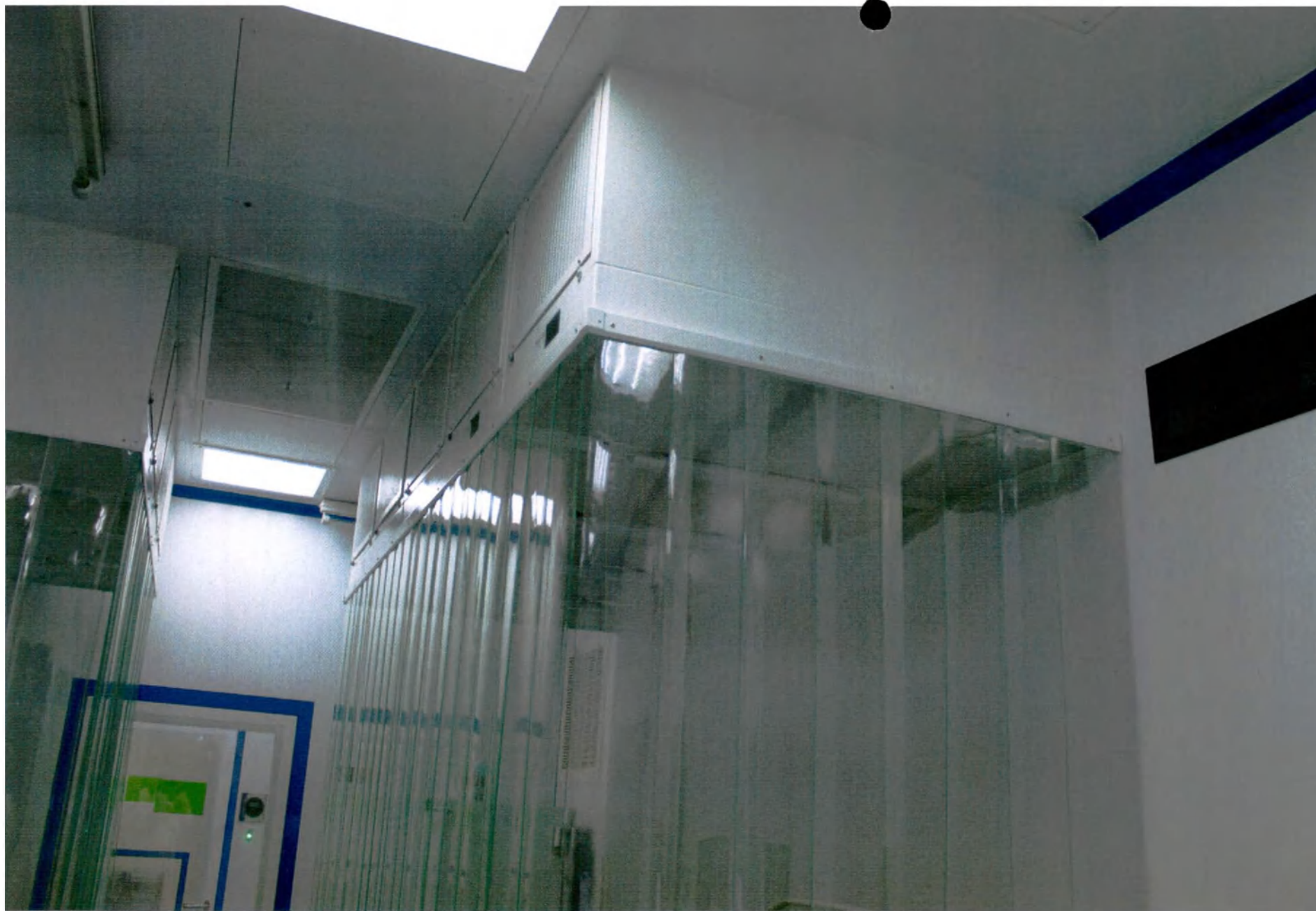
Формирующие ламинарные воздушные потоки, производства ЗАО «Ламинарные системы» (РФ); Компания «Тсион» (РФ); Компания GEA(Германия)
