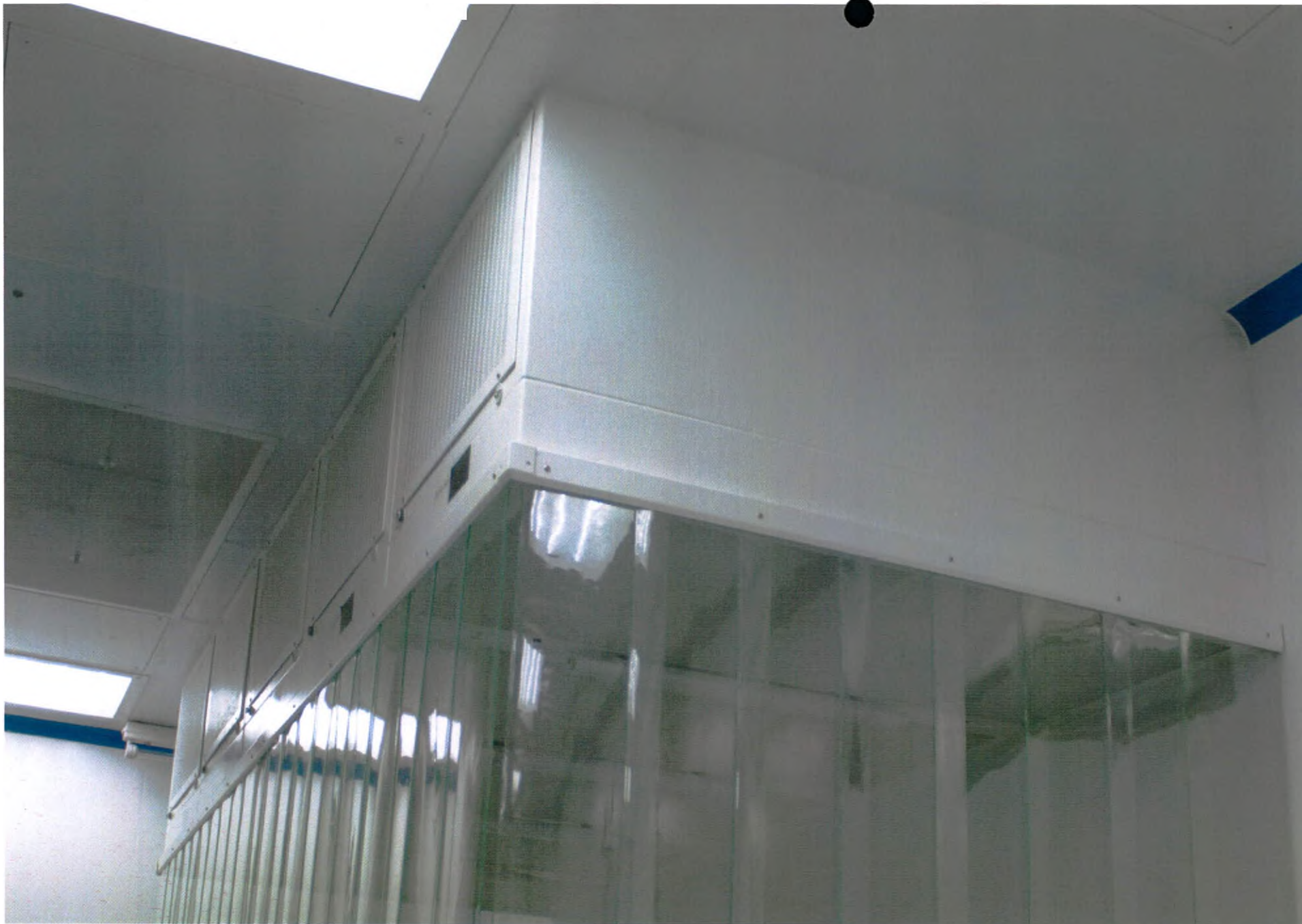
Фильтровентиляционные модули, производства Компания ОИК (РФ)
