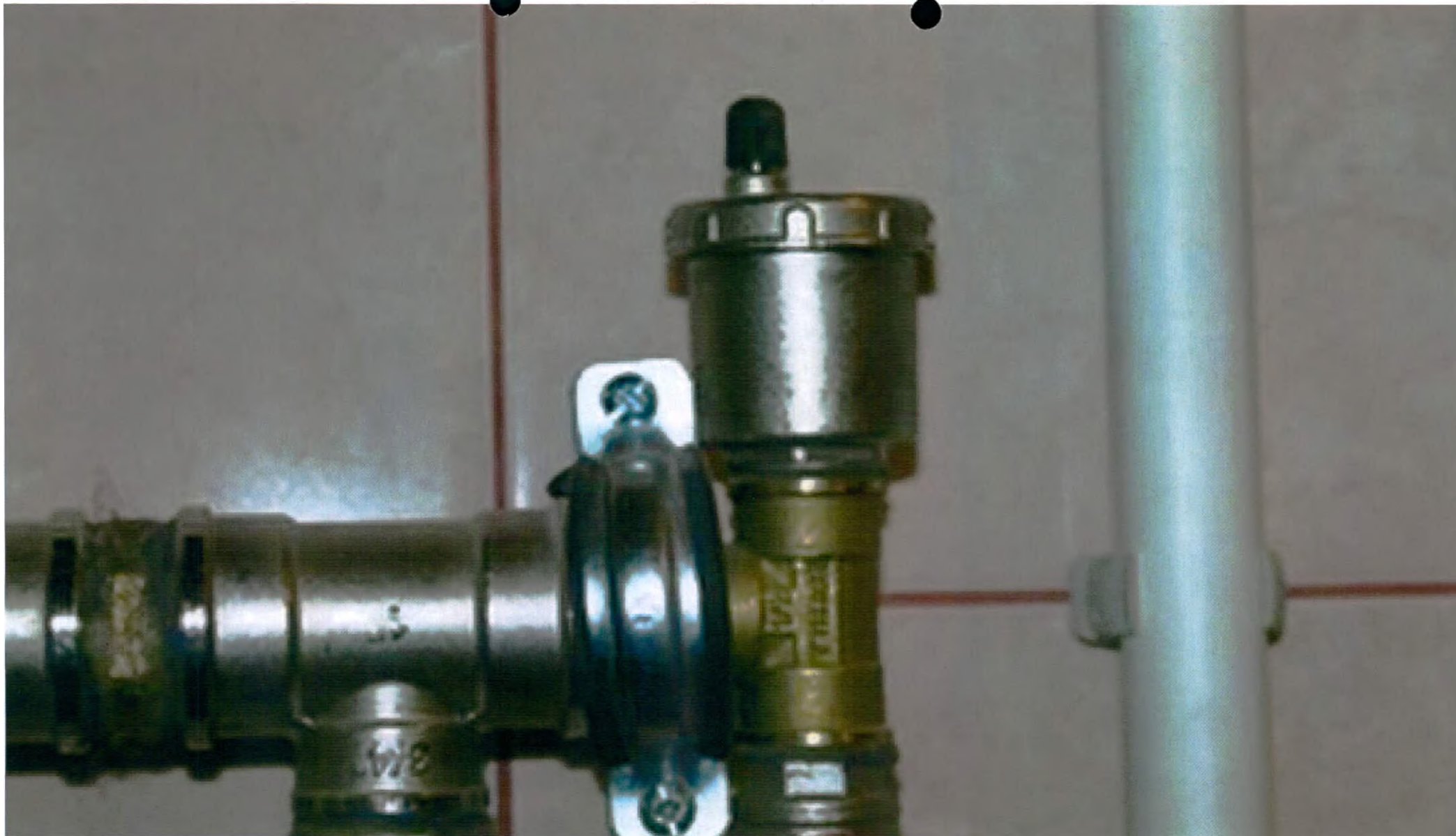
Воздухоотводчики автоматические 065BXXXX, производства «Danfoss A/S» (Дания)
