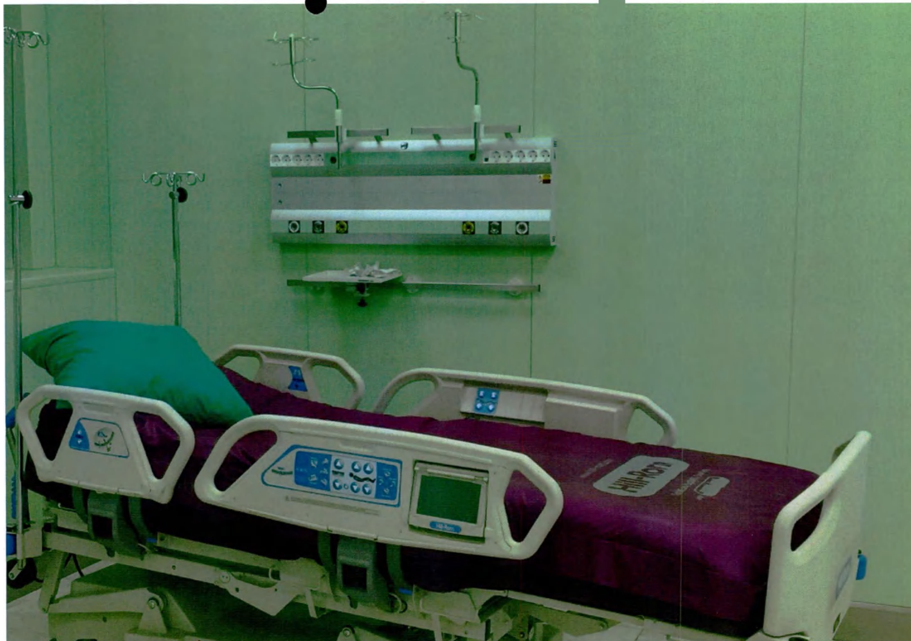
Консоль для распределения медицинских газов и электропитания реанимационная с настенным креплением, варианты исполнения: RN07/D0, RN07/D1, RN07/D2, RN07/D3 RN07/D4, ZS 07, производства «MZ Liberec, a.s.» (Чехия)
