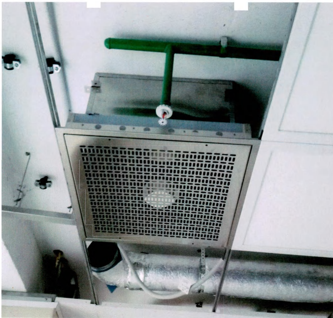
Панель воздухораспределительная потолочная V1; V2; V3; V4; VL , производства ООО «НПО КОССМЕД» (РФ); ООО «Алгори-М» (РФ)
