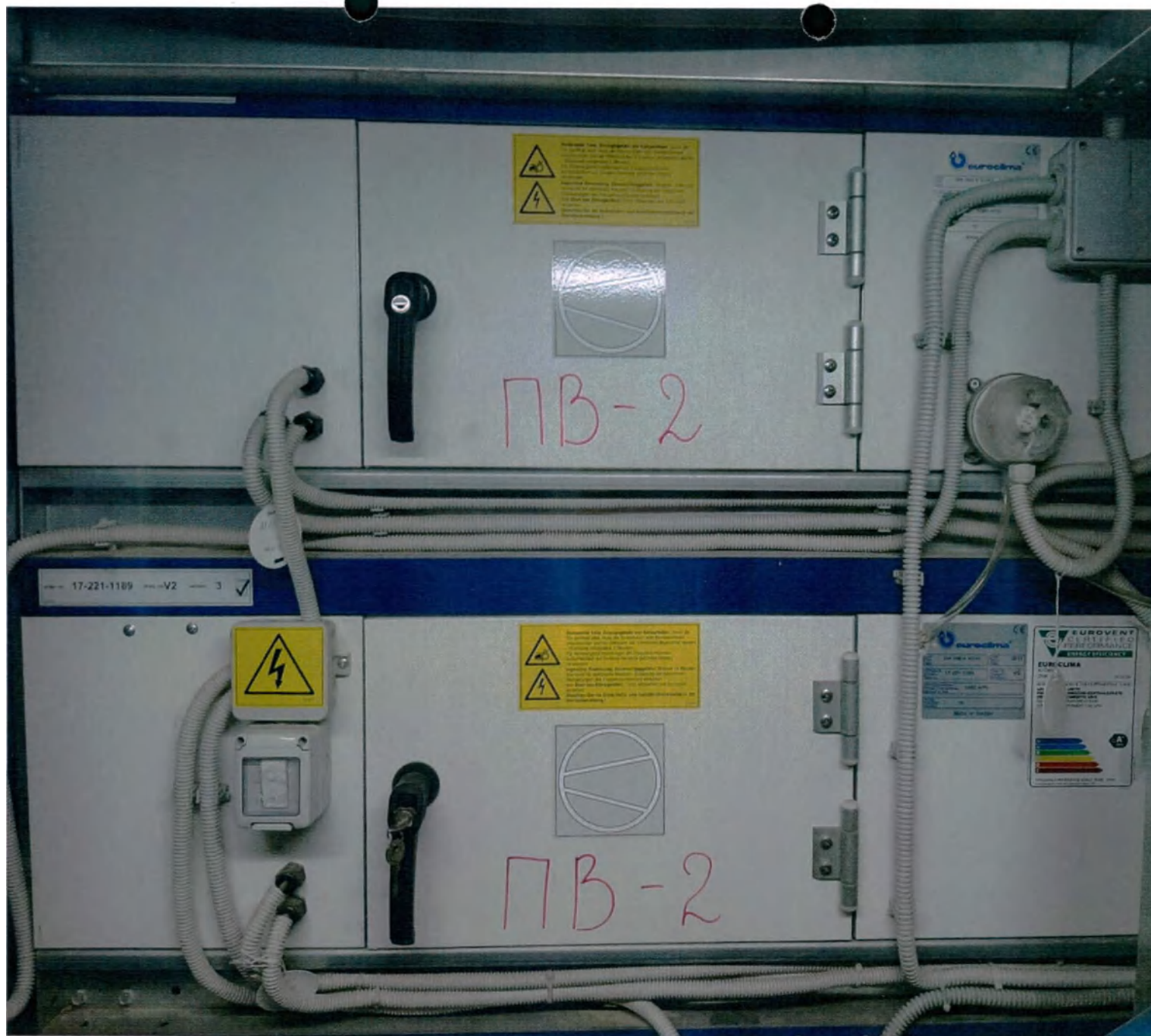
Установка обработки воздуха медицинская EUROCLIMA, модель ZHK 2000, производства «EUROCLIMA SpA» (Италия)
