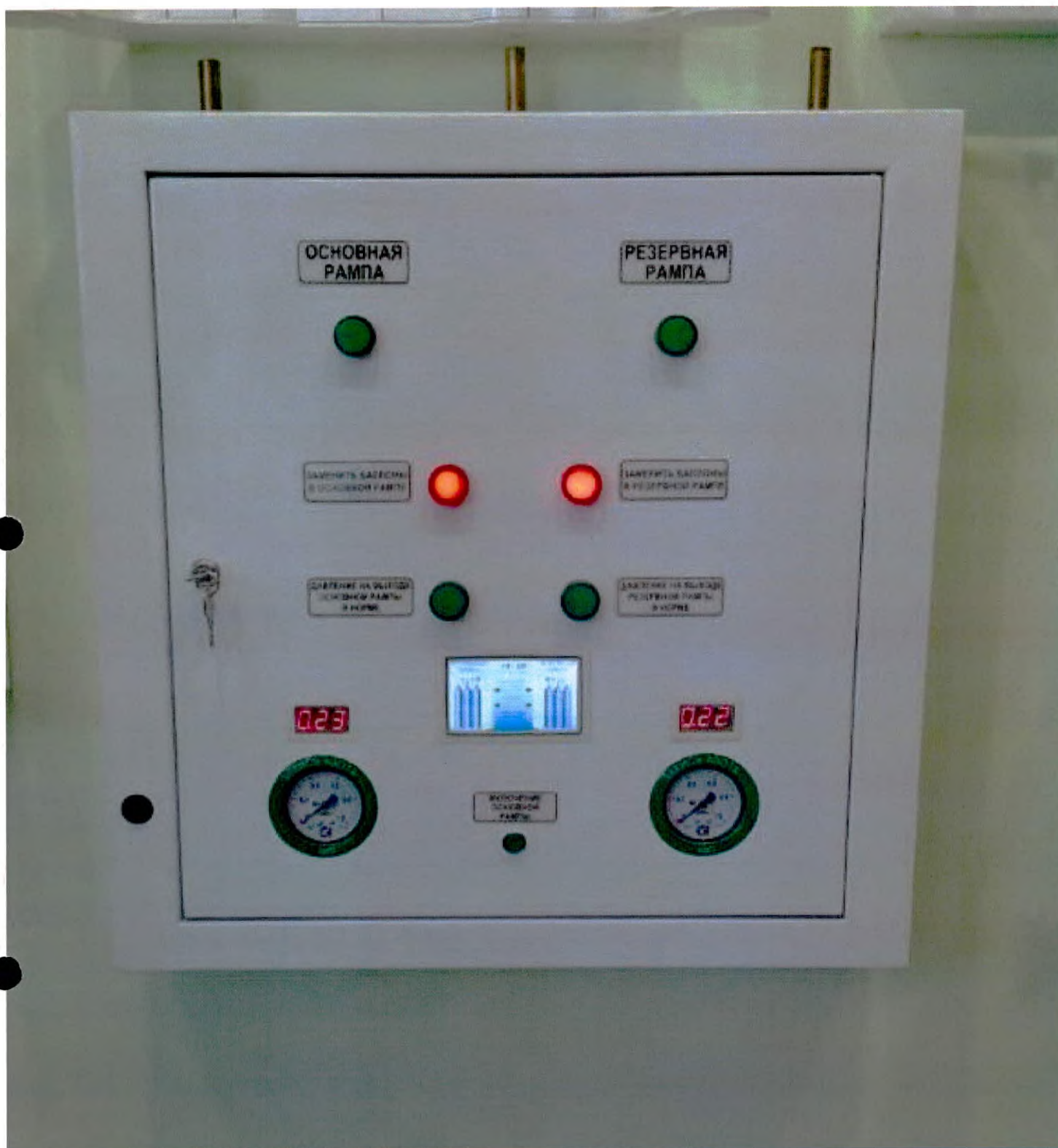
Щит управления для газобаллонной станции медицинского назначения ЩУГБС, производства Корпорация СоТиС (РФ)
