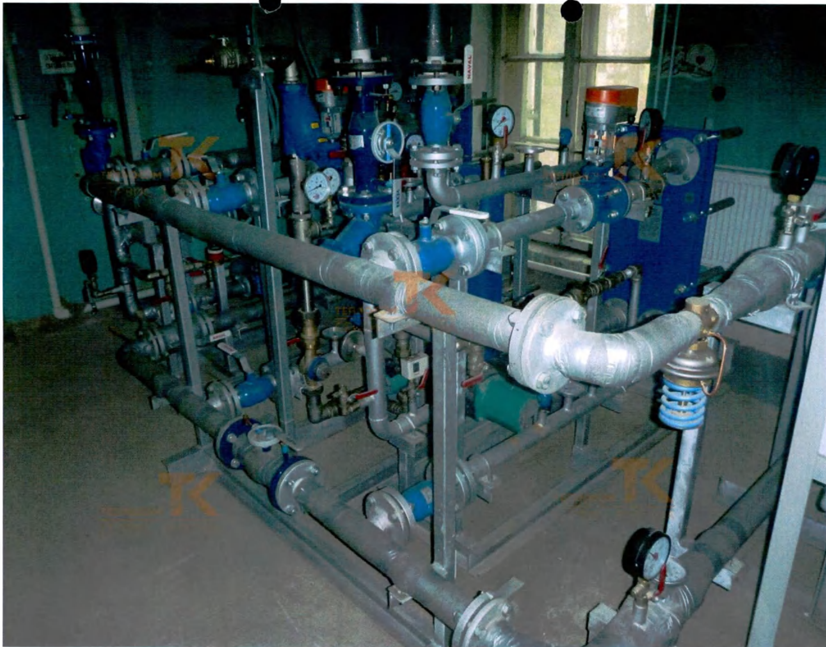
Блочные индивидуально тепловые пункты (БИТП), производства ООО «Уралтехнология», ТУ 4938-001-32277111-2013 (РФ); ООО ИТЦ «Карат» (РФ)
