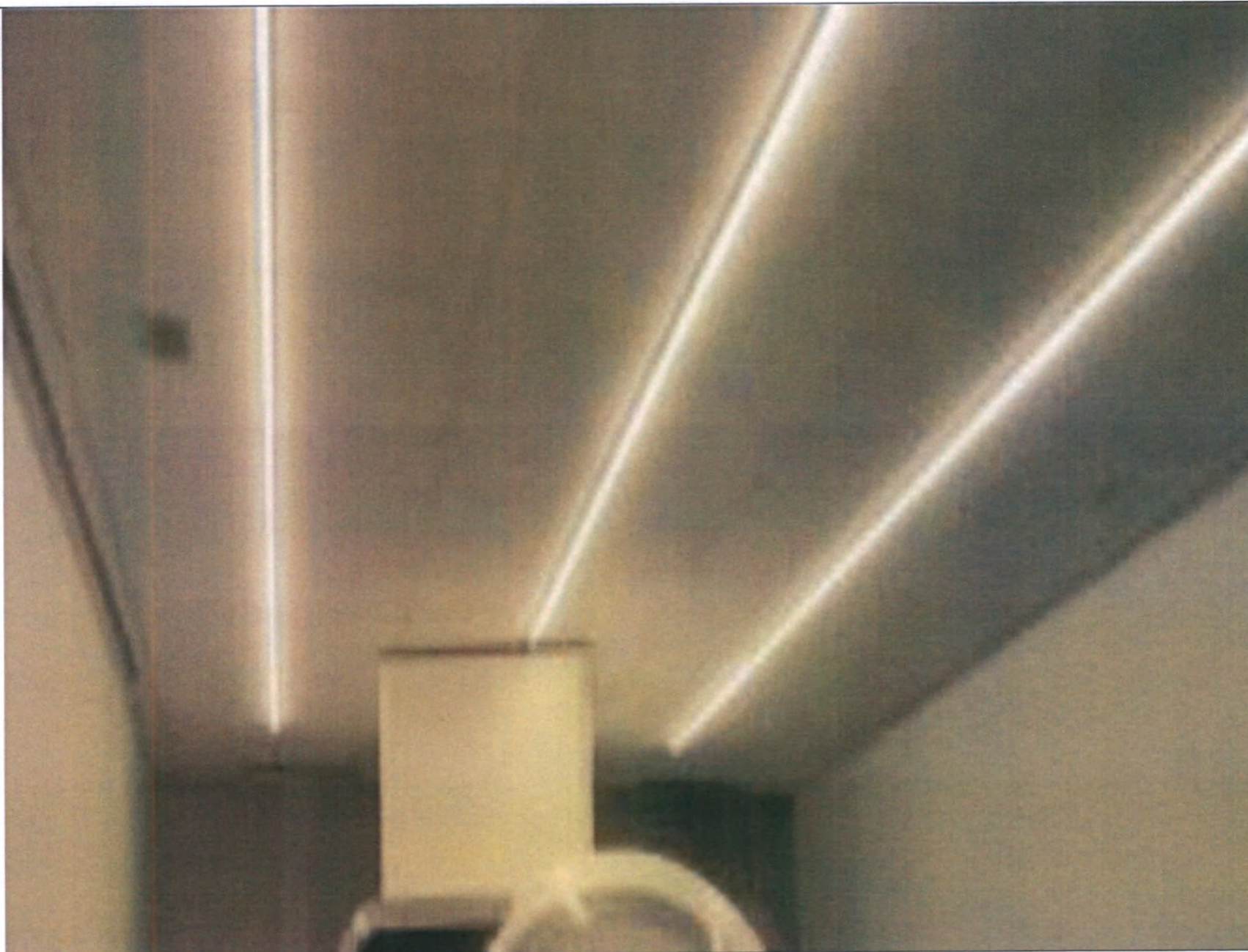
Облицовка радиочастотной кабины
