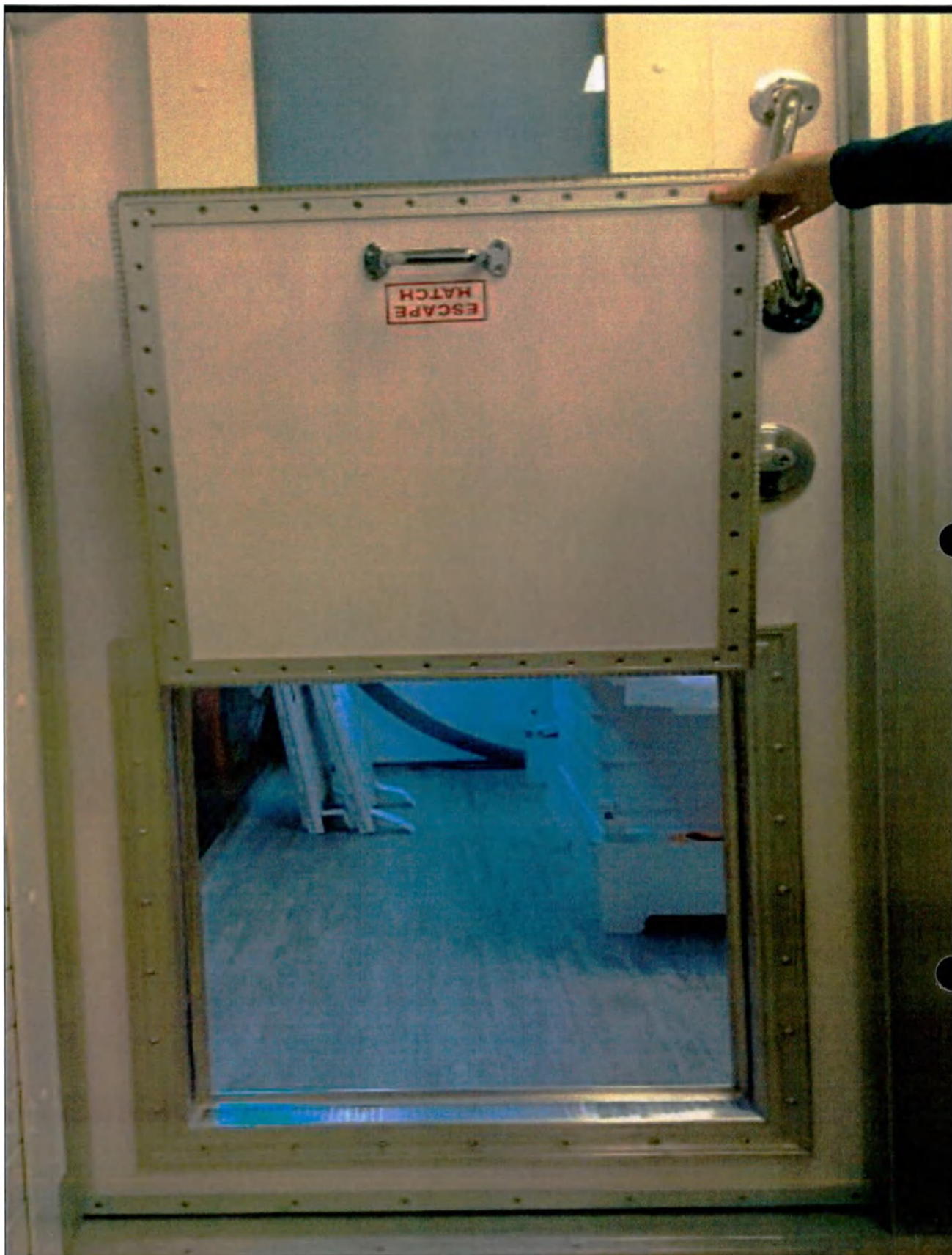
Люки аварийные для экстренной эвакуации
