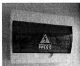
Рисунок 3. Навесной электрический распределительный щит.
