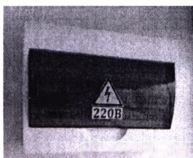
Рисунок 3. Навесной электрический распределительный щит.
