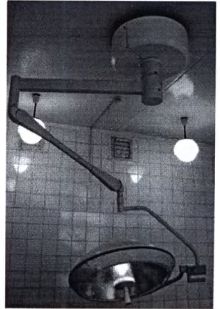
Рисунок 4. Одноблочный светильник с потолочным подвесом Аксима-720
