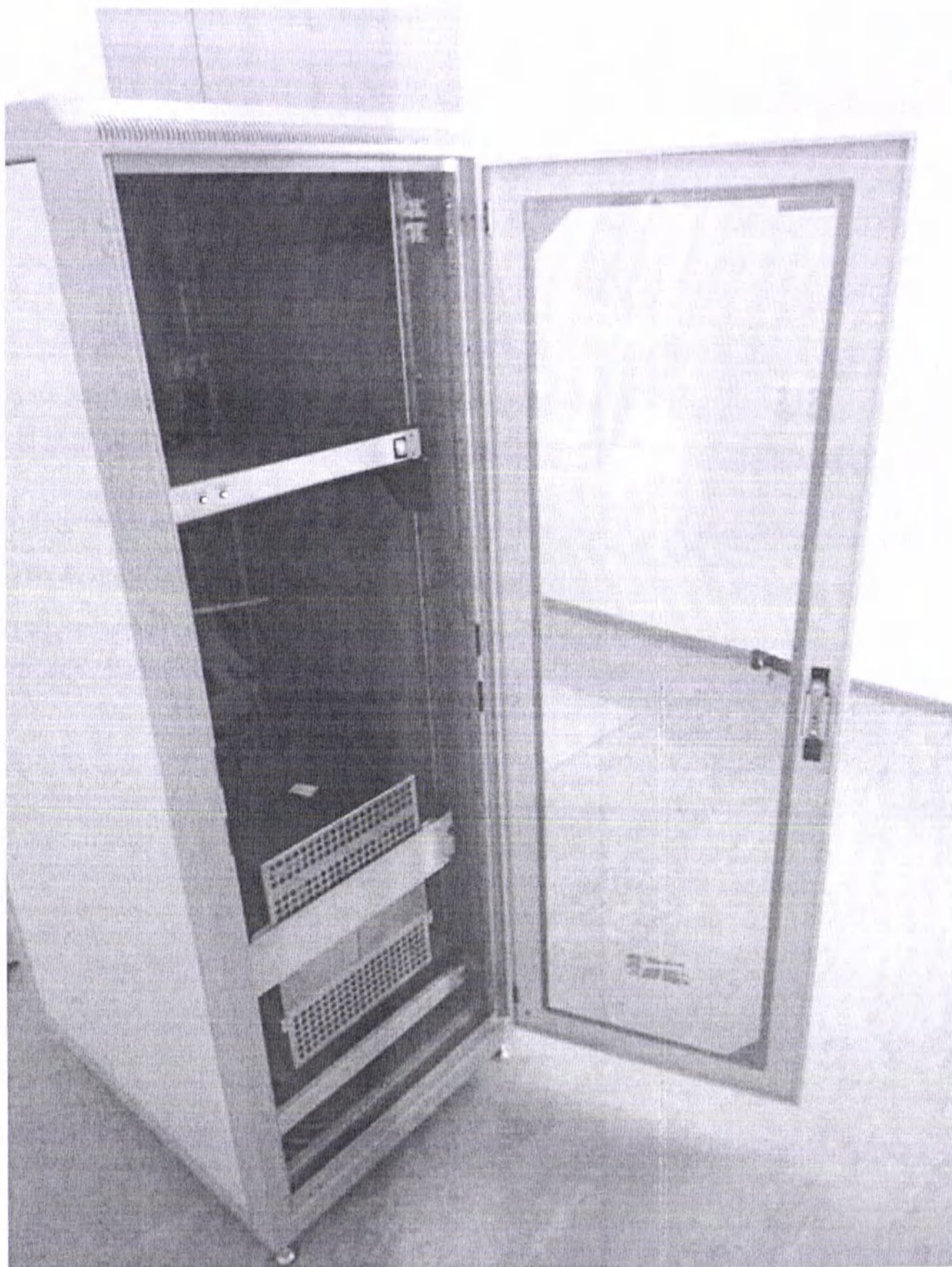
Фотография 3.28 – Шкаф управления СТМ-00-0600. Вид спереди с открытой дверью, производство АО «НИПК «Электрон», Россия
