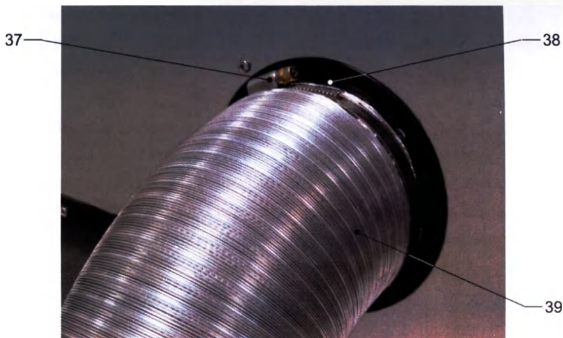
Рисунок 1-ИМ. Подключение к вентиляции.
