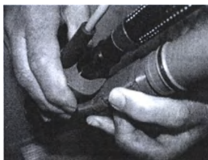
Рисунок 2-6 Фиксация воздуховода ВСО
