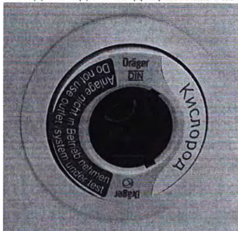
Рисунок 4.1.11 Газовый разъем для подачи медицинских газов: Кислород Используется для подачи кислорода.
