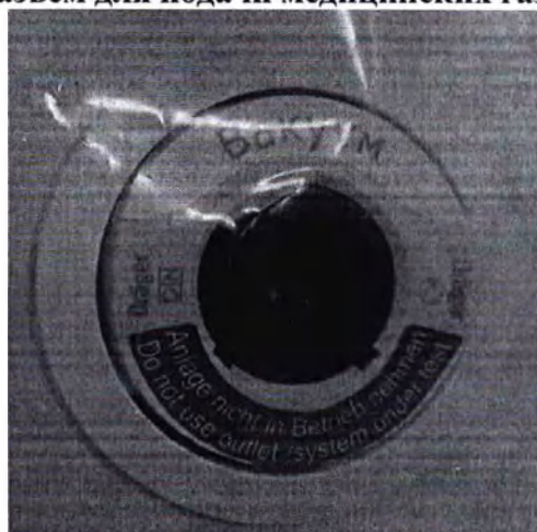
Рисунок 4.1.13 Газовый разъем для подачи медицинских газов: Вакуум Используется для подачи вакуума.
