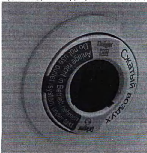
Рисунок 4.1.10 Газовый разъем для подачи медицинских газов: Сжатый воздух Используется для подачи сжатого воздуха.
