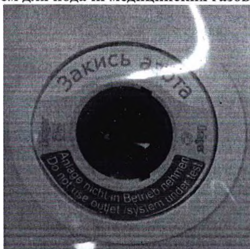
Рисунок 4.1.12 Газовый разъем для подачи медицинских газов: Закись Азота Используется для подачи закиси азота.
