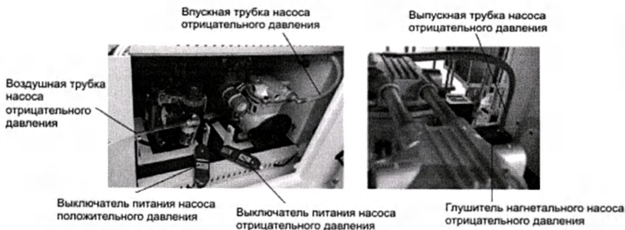
Рисунок 15 – Установка компрессора воздушного и насоса вакуумного
