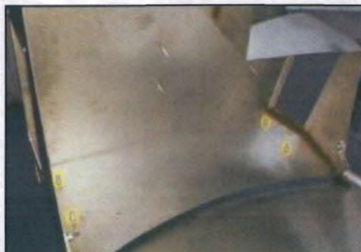
Рисунок 70 Место крепления резервной батареи
