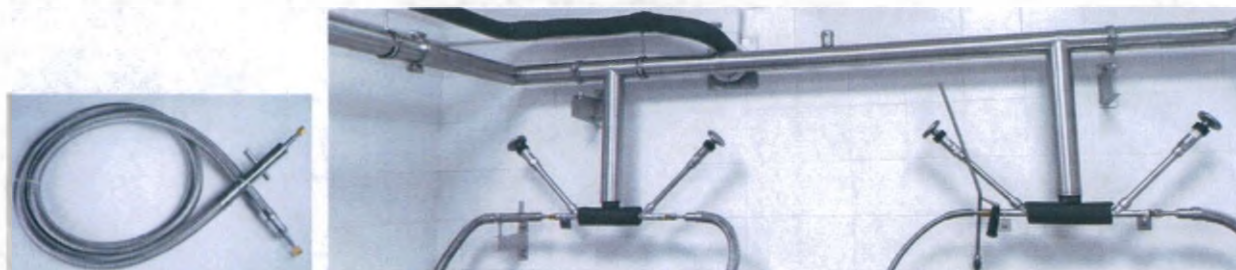
Рисунок 23 Внешний вид шланга криогенного и трубопровода криогенного для соединения резервуара и MVE криобиологического морозильного аппарата
