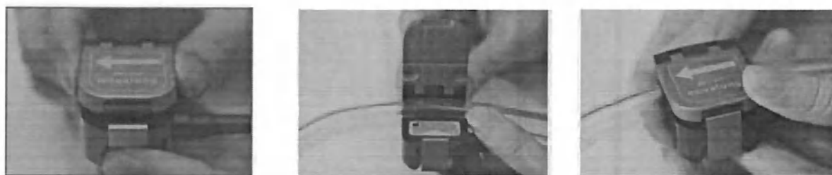
Рисунок 28– Последовательность установки датчика потока на магистраль
