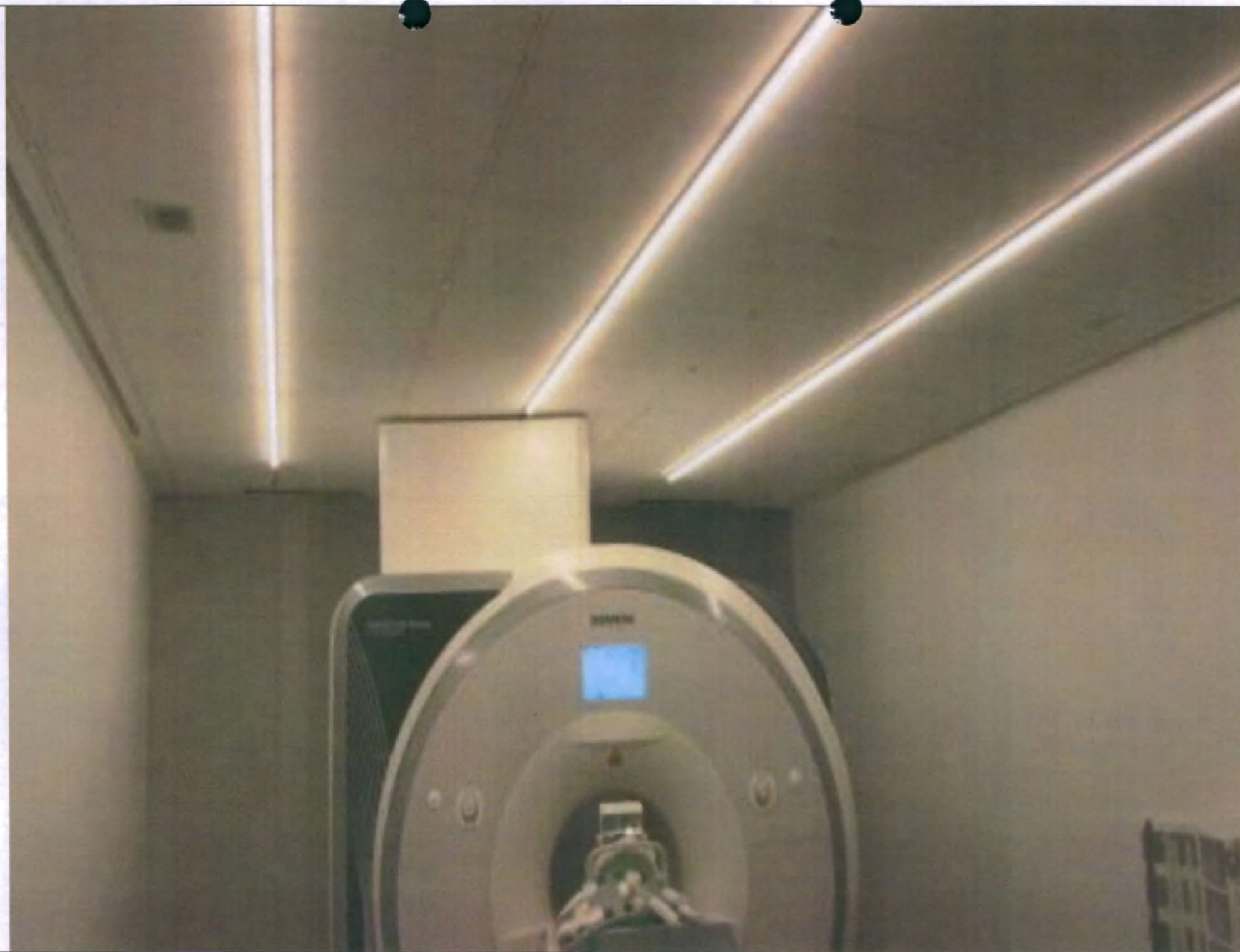
70. Облицовка радиочастотной кабины.
