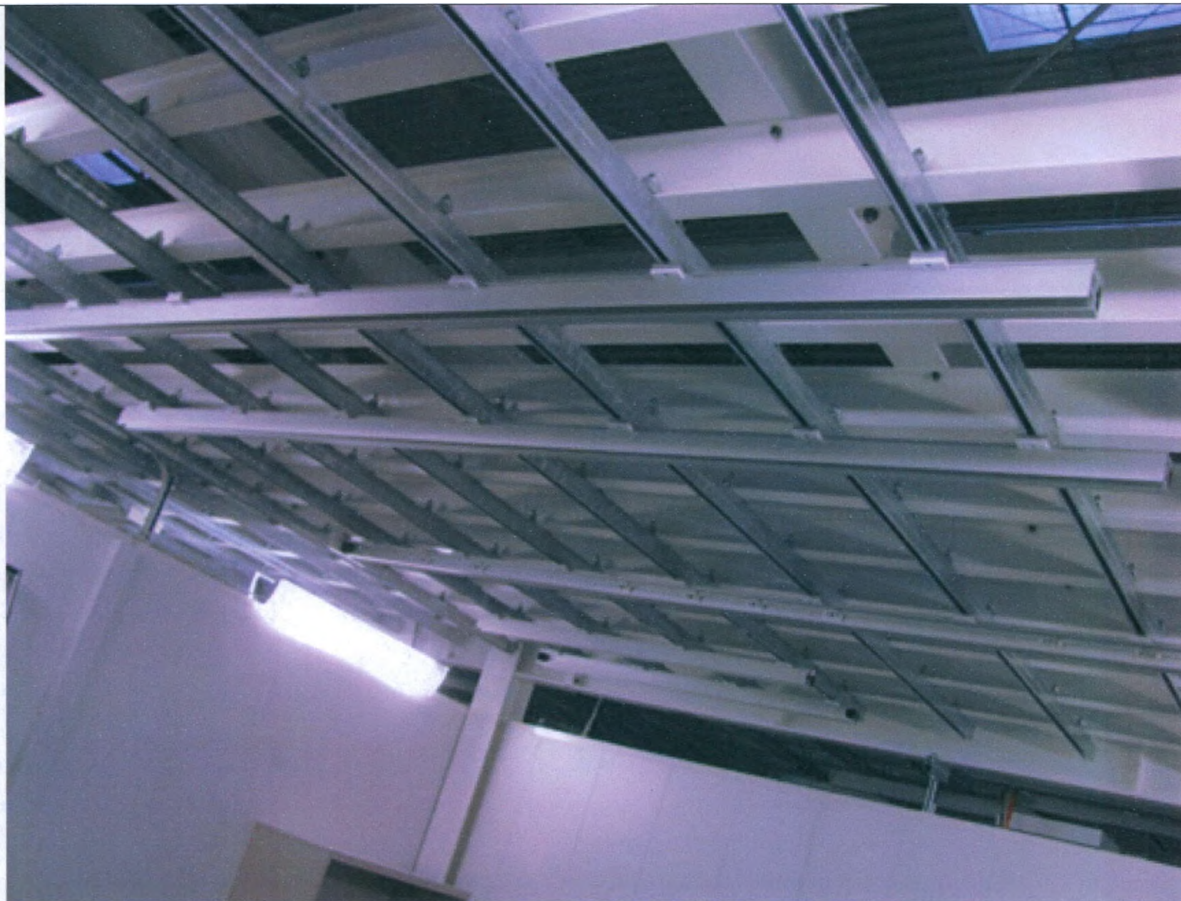
57. Удлинение потолочных рельсов.
