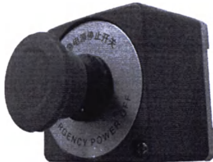
Рисунок 13.23 Кнопка аварийного отключения питания системы
