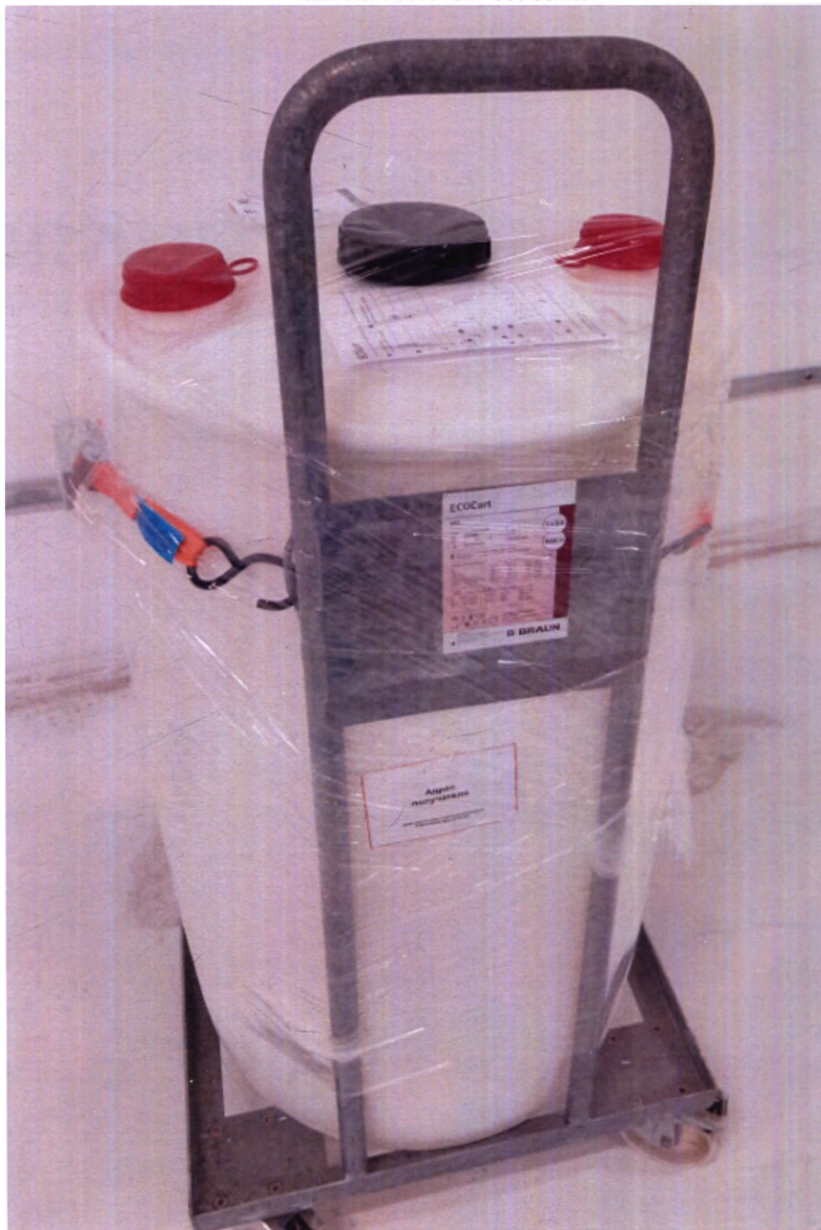
Фото 9. Солевой картридж для гемодиализа ECOCart Revolution на тележке, тип DSK-0673-GW-800-35-Rev
