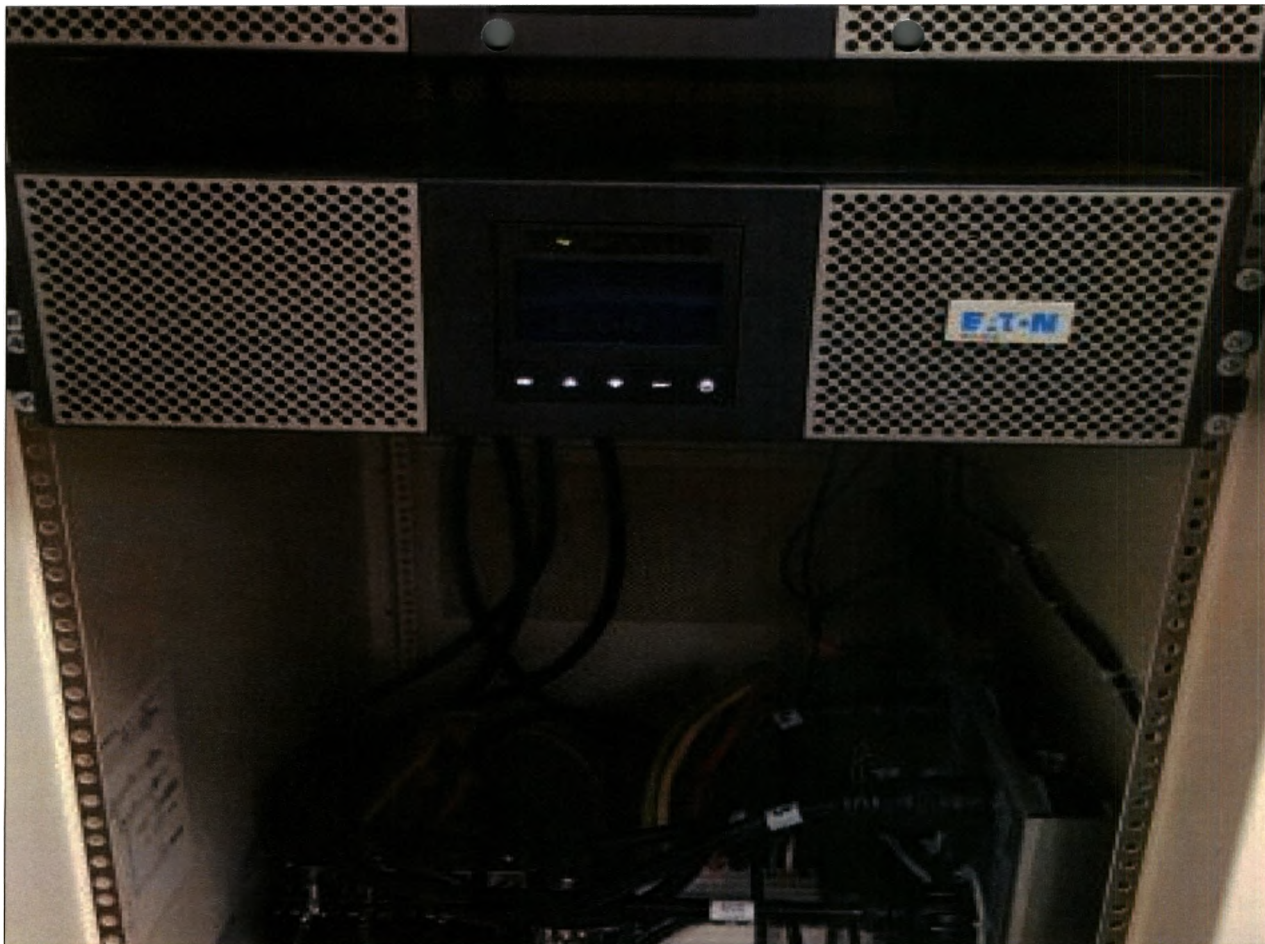
31. Источники бесперебойного питания для ПЭТ гентри
