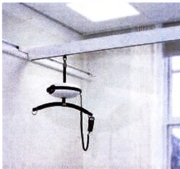
Рис.3. Размещение подъемника и направляющих на потолке
