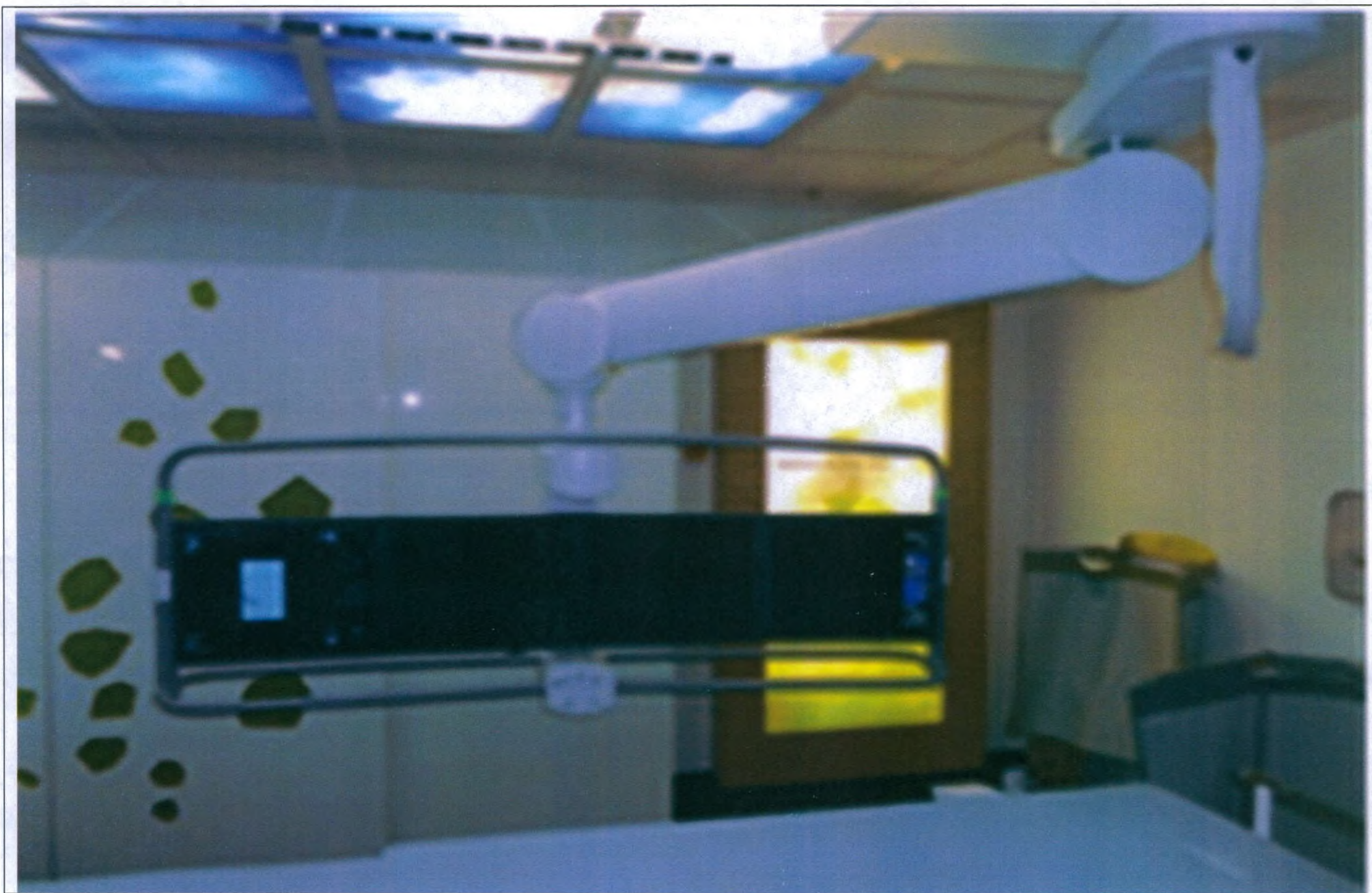
9.2 Потолочная подвеска мониторов (DCS) с ЖК-дисплеями или с большим дисплеем в операционной.
