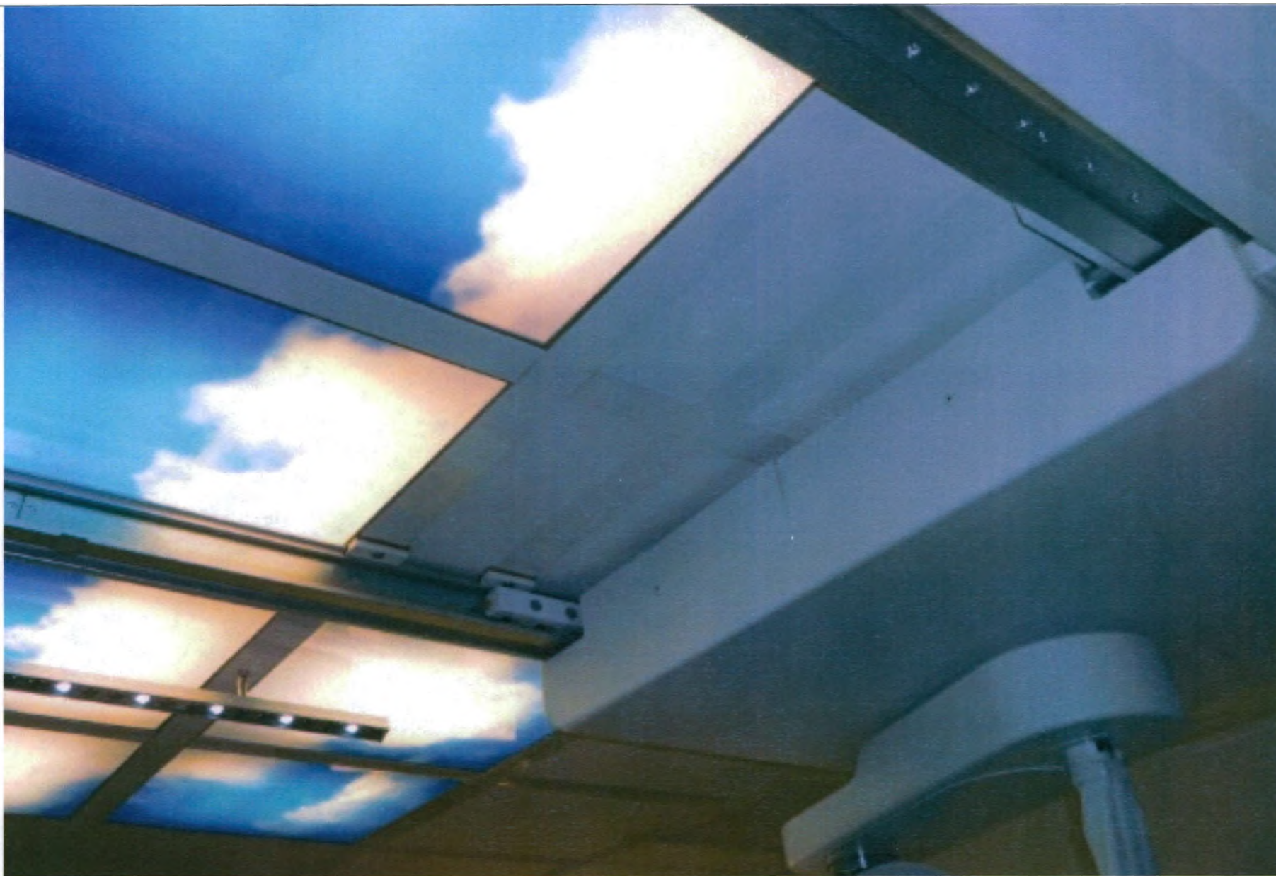
47. Дополнительные направляющие для удлинения потолочных направляющих, длиной 1,2 метра.
