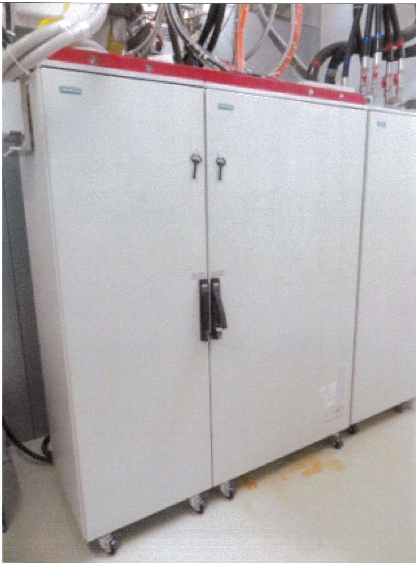
7. Шкафы с электронной аппаратурой для управления системами сбора данных томографа: шкаф градиентов; шкаф управления.
