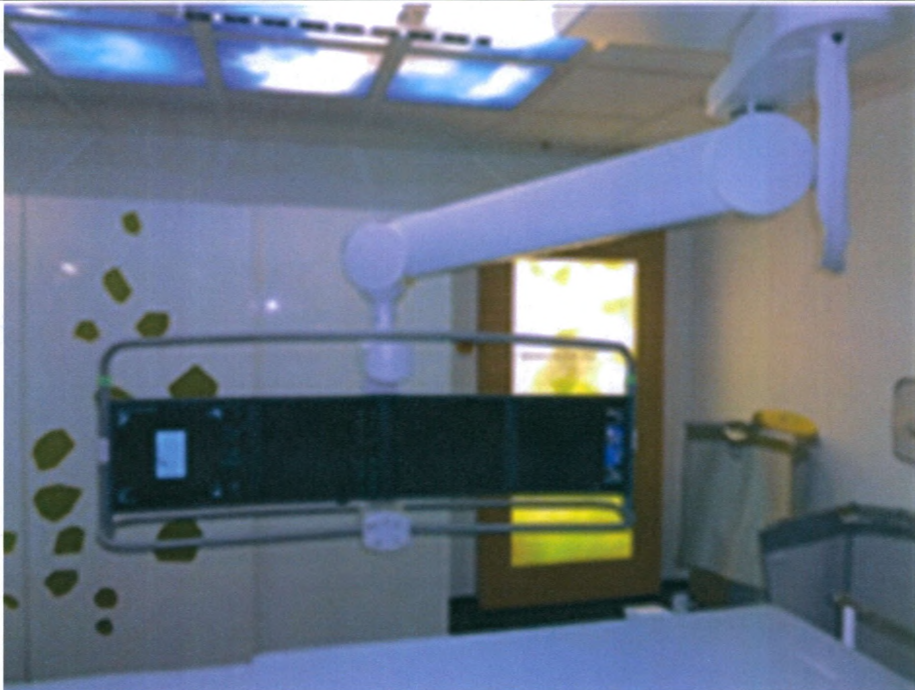
9.2. Потолочная подвеска мониторов (DCS) с ЖК-дисплеями и/или с Large Display (Большой Дисплей) в операционной.
