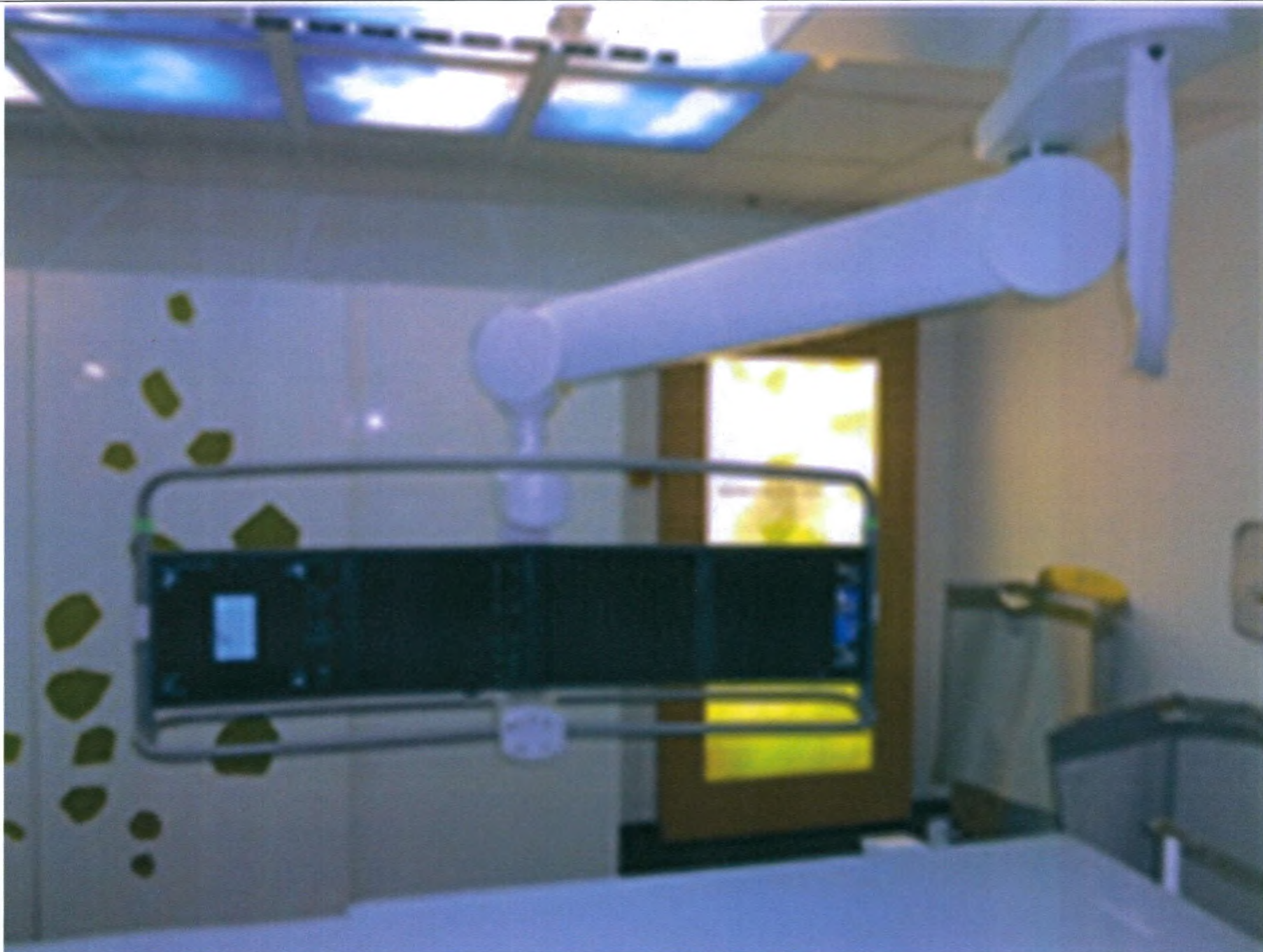
10.2. Потолочная подвеска мониторов (DCS) с ЖК-дисплеями или с Large Display (Большой Дисплей) в операционной.
