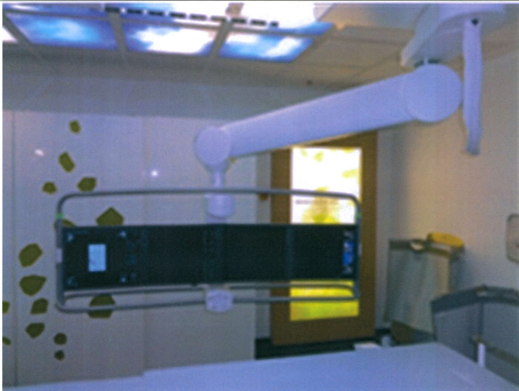
7. Потолочная подвеска мониторов (DCS) с ЖК-дисплеями или с Large Display (Большой Дисплей) в операционной.
