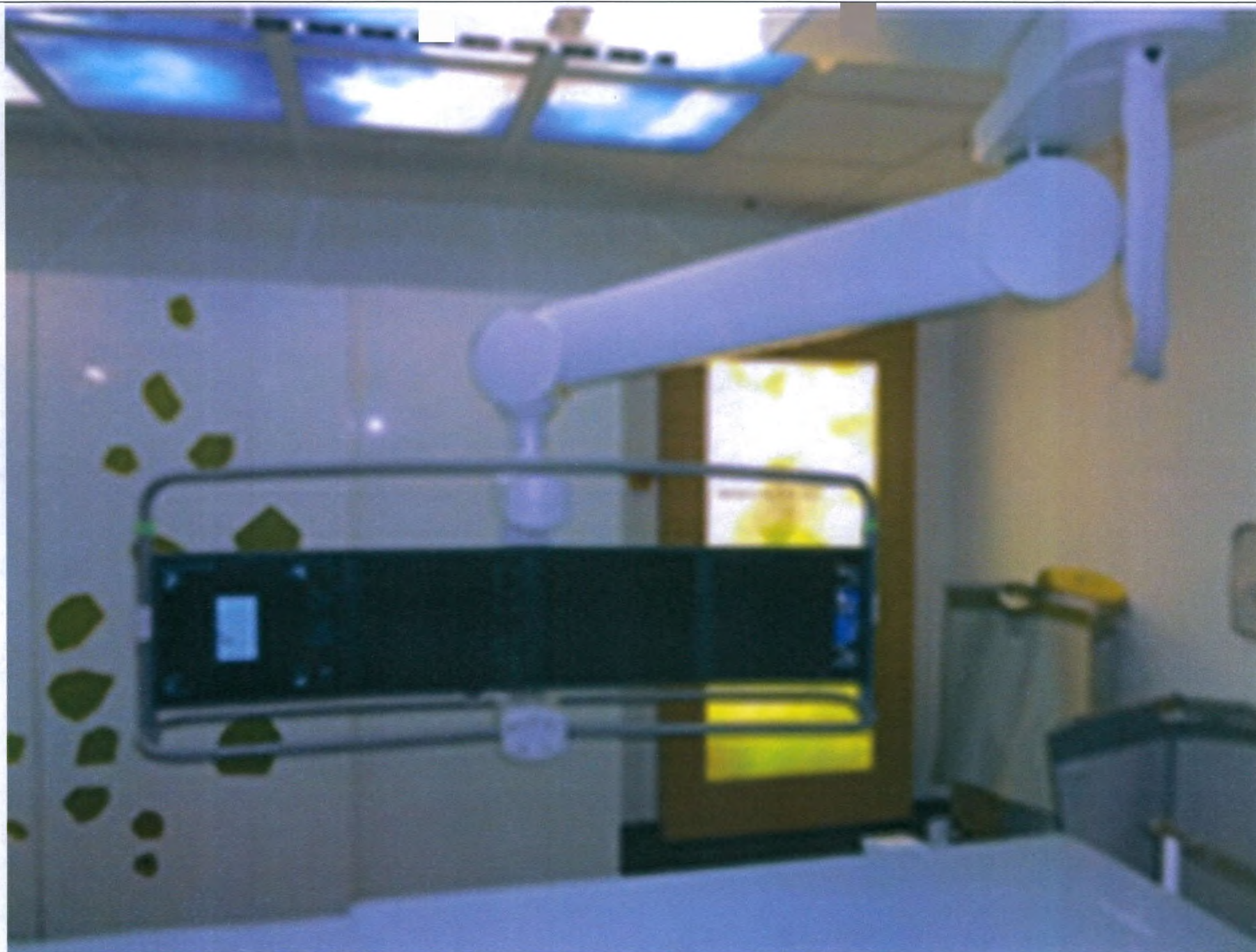
5.2. Потолочная подвеска мониторов (DCS) с ЖК-дисплеями или с Large Display (Большой Дисплей) в операционной.
