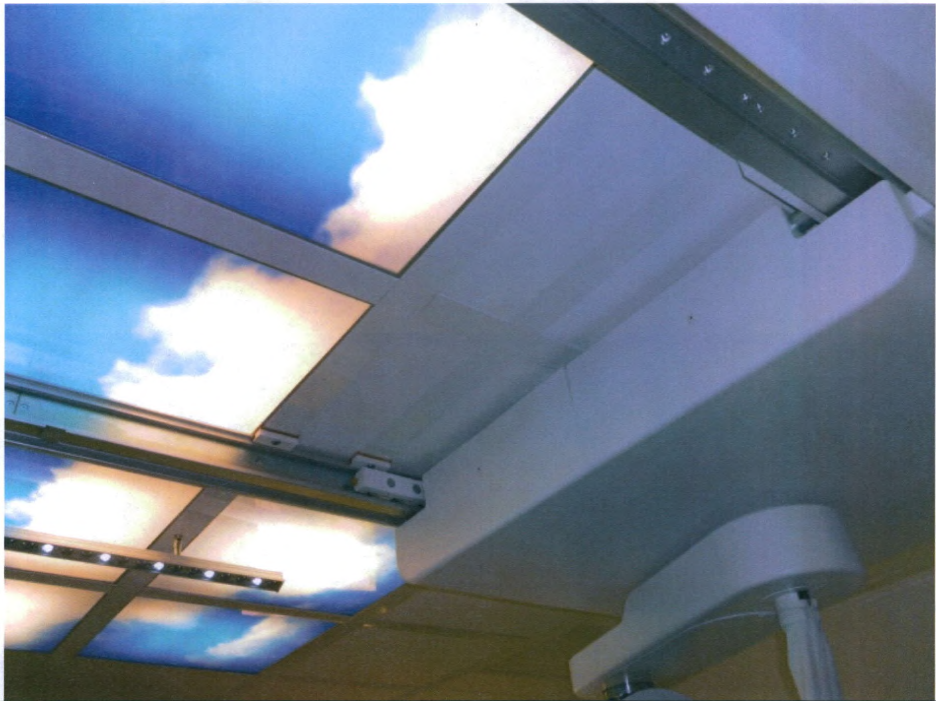
47. Дополнительные направляющие для удлинения потолочных направляющих, длиной 1,2 метра
