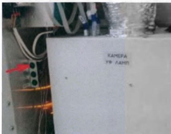
Рисунок В.4 - Технический отсек. Камера УФ облучения воздуха. Кнопка «Сброс УФ».
