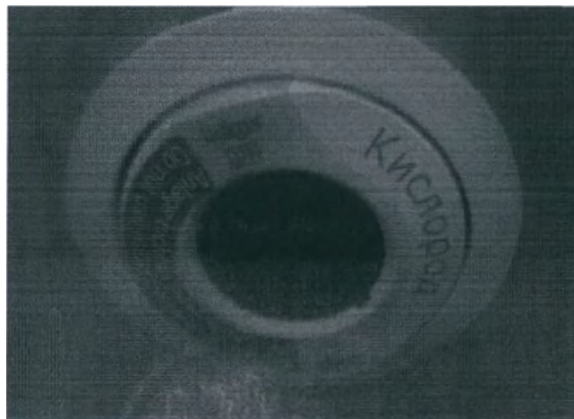
Рисунок 5.1.19 Разъем для подачи кислорода
