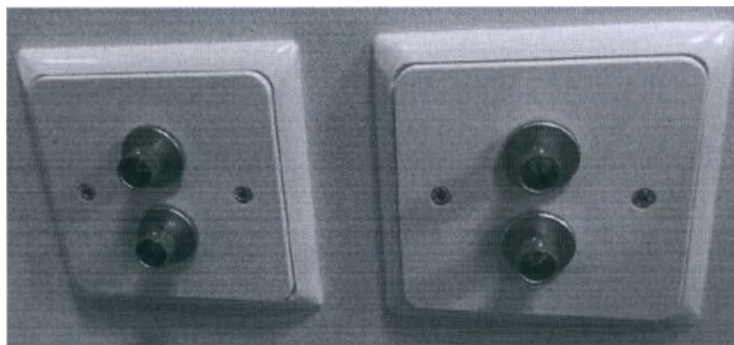
Рисунок 5.1.16 Двойной разъем BNC
