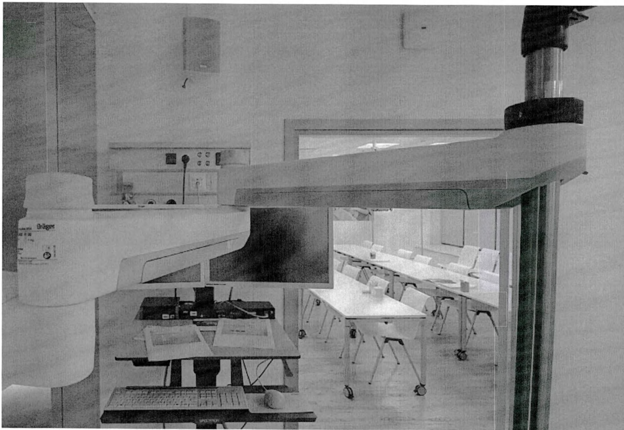
Рисунок 23. Дополнительный несущий кронштейн на примере дополнительного двойного кронштейна для размещения оборудования
