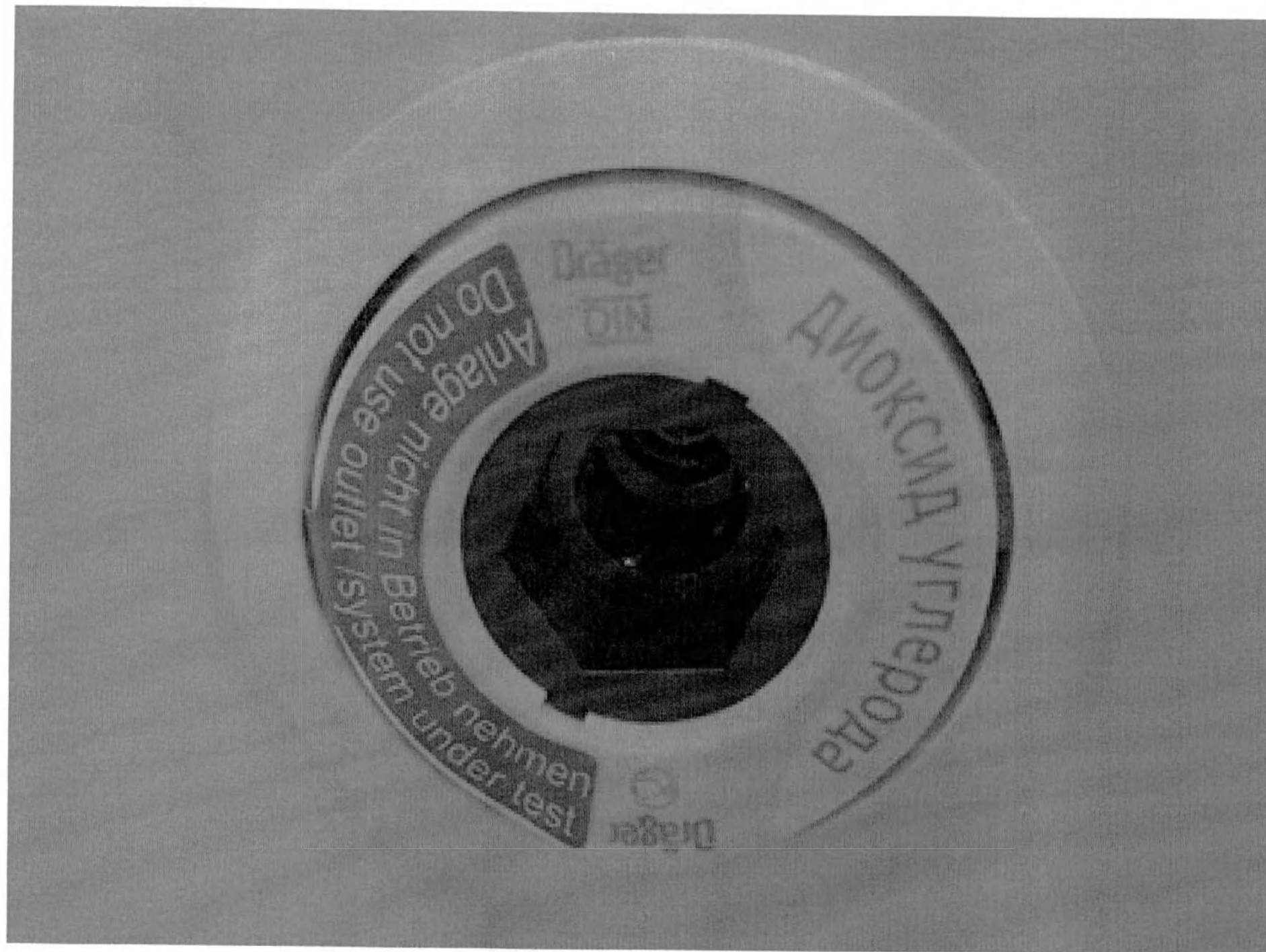
Рисунок 14. Газовый разъем для подачи медицинского газа: диоксид углерода
