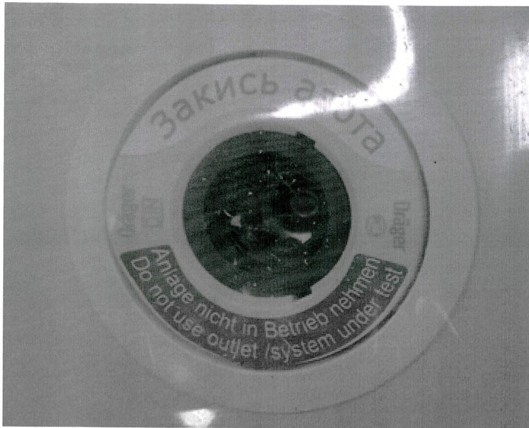
Рисунок 12. Газовый разъем для подачи медицинского газа: закись азота
