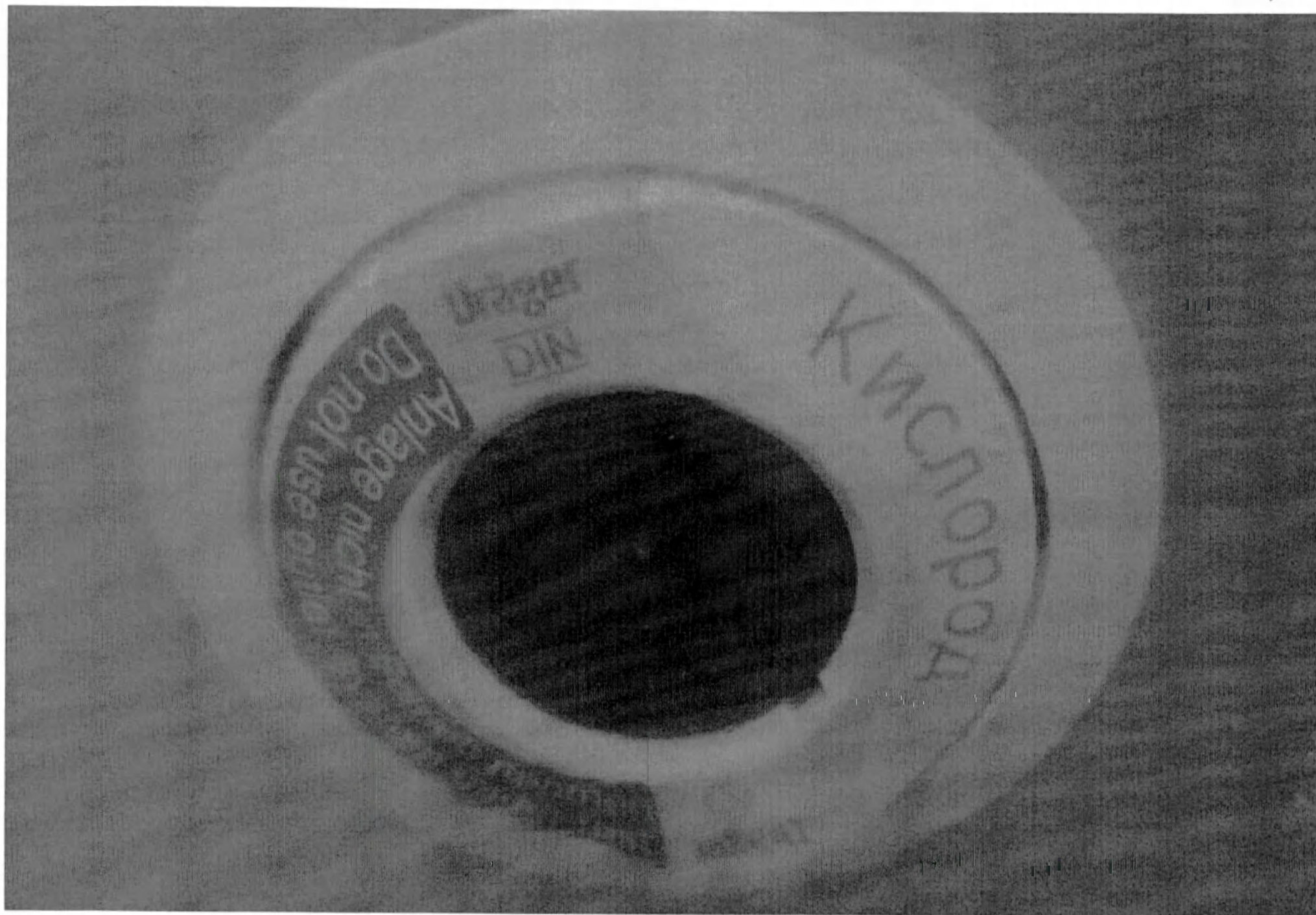
Рисунок 11. Газовый разъем для подачи медицинского газа: кислород
