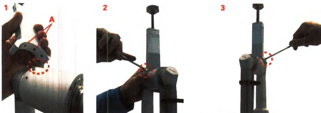
Рисунок 24. Установка опорного элемента
