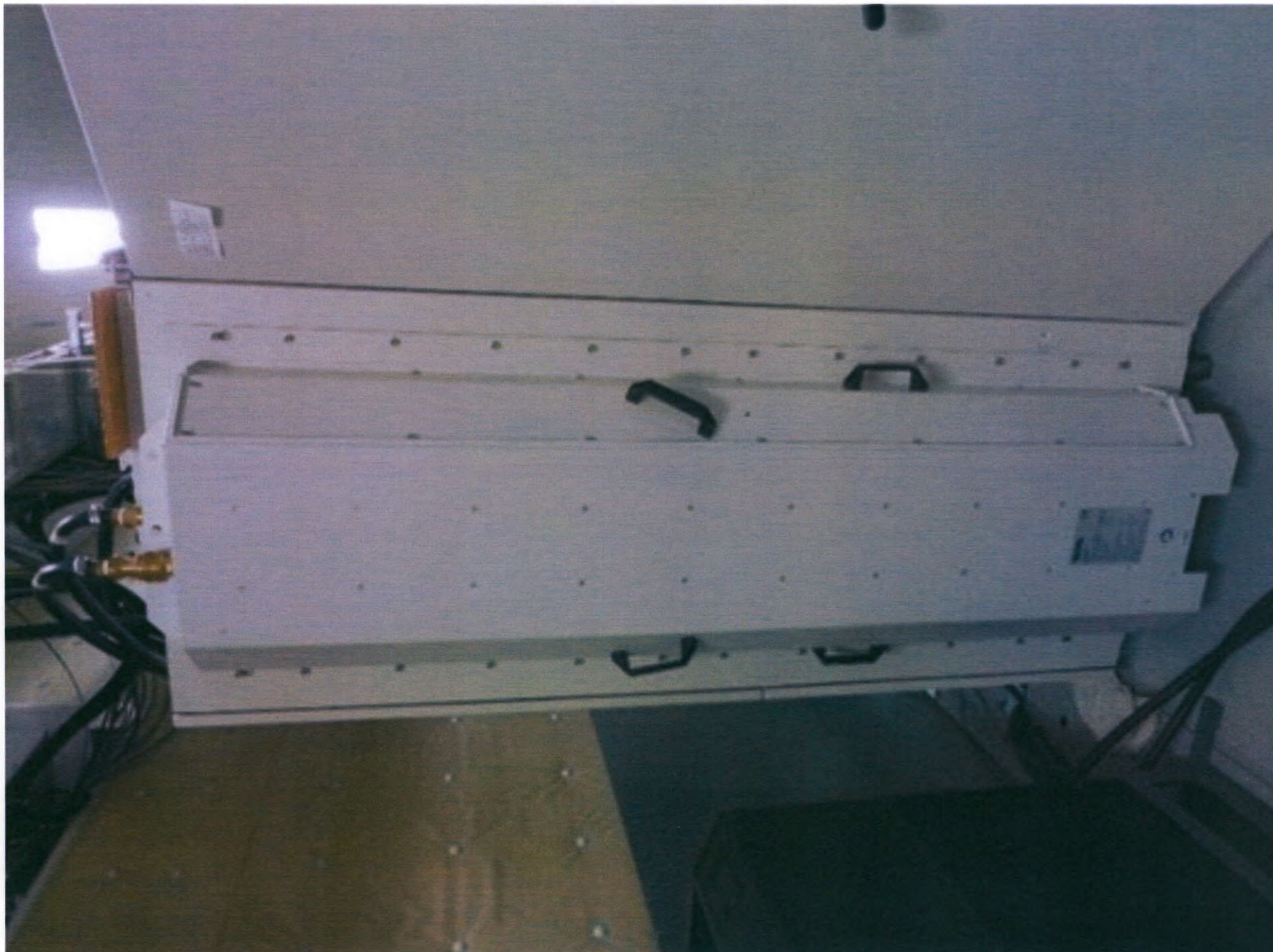
12. Блок охлаждения для градиентной катушки и компонентов основного блока управления
