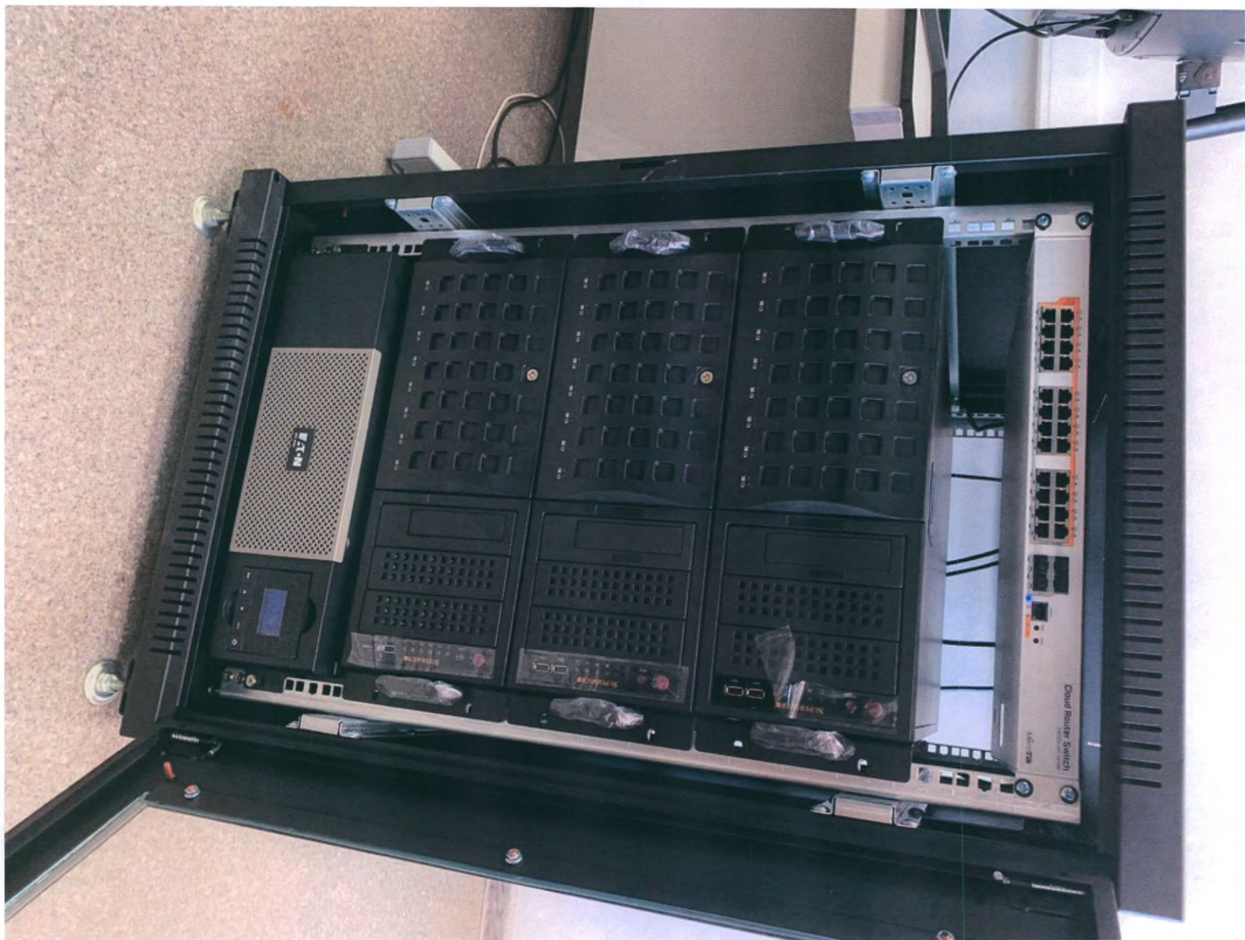
Рисунок 38. Серверная стойка (с открытой дверью).
