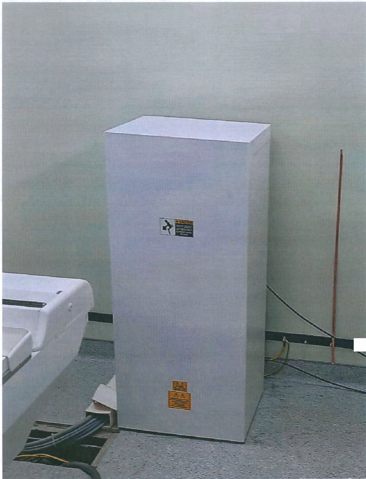
Рис. 1. Рентгеновское питающее устройство: Силовой шкаф.
