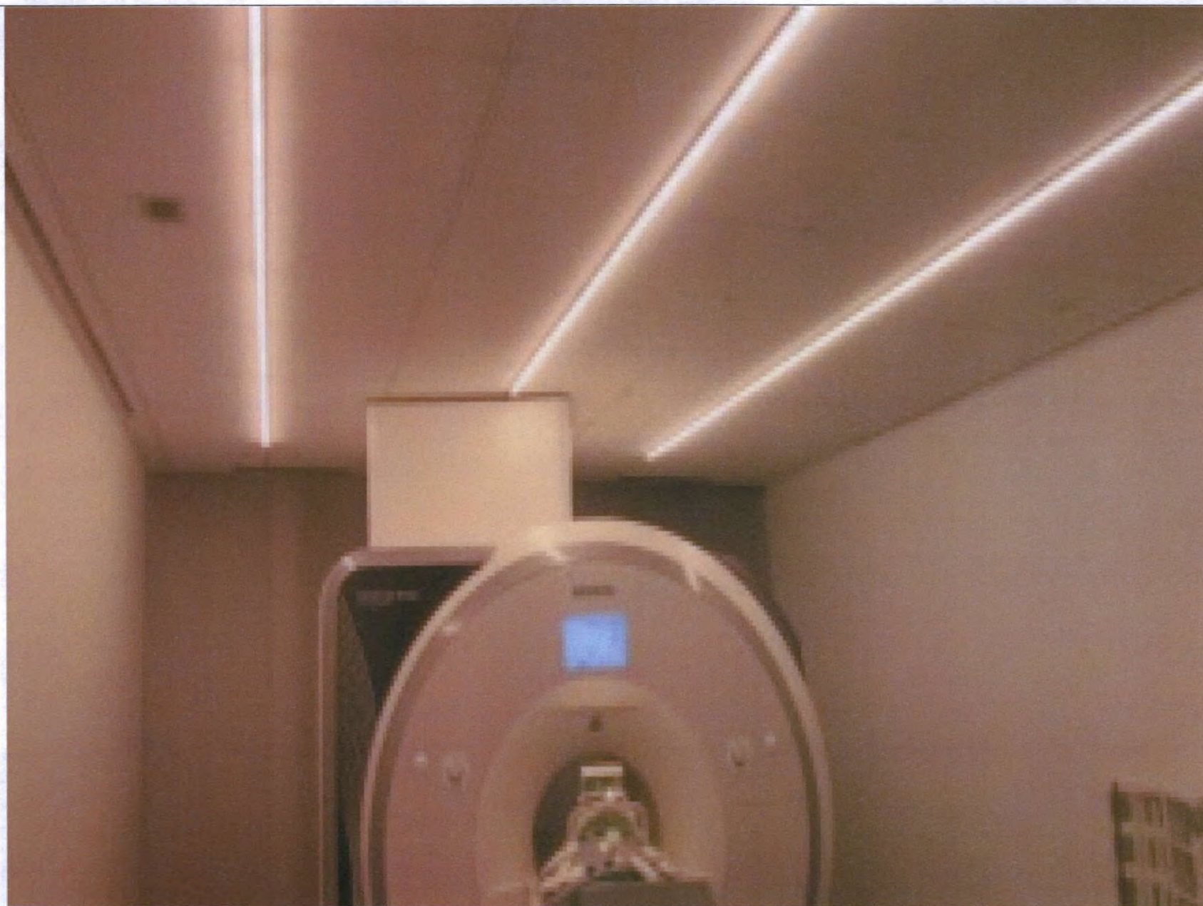
71. Облицовка радиочастотной кабины.
