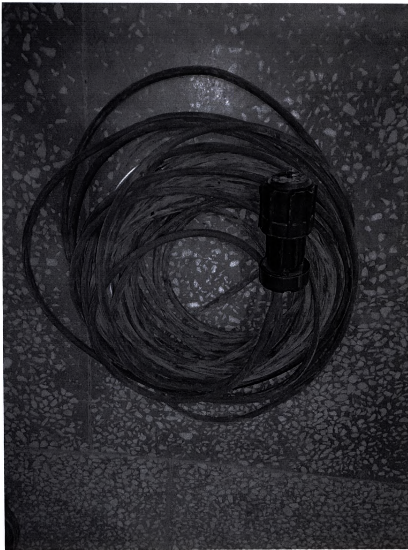
Фотография 5. Кабель для подключения внешнего электропитания 220В, 30м.Общий вид.
