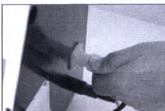
Рисунок 5.6 – Подсоединение кабелей к модулю подогрева/сушки стёкол
