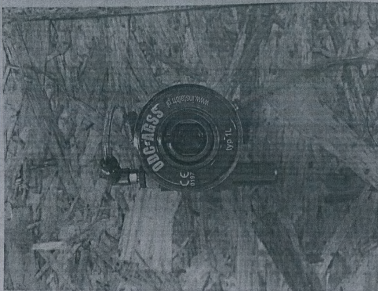
ФОТО 51. Разъем AGSS пассивный (AGSS outlet, passive) EN ISO 9170-2
