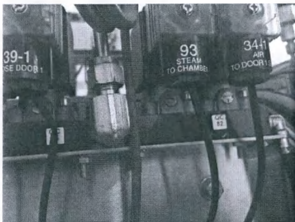
Рисунок 8 Электромагнитные клапана управления
