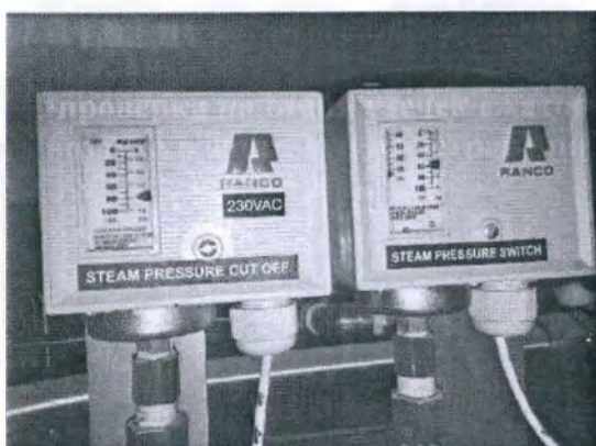
Рисунок 3 Регуляторы давления пара
