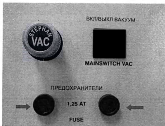
Рис. 11 Замена 1.25 А предохранителей
