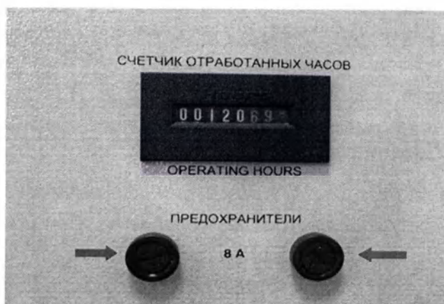
Рис. 10 Замена 8 А предохранителей
