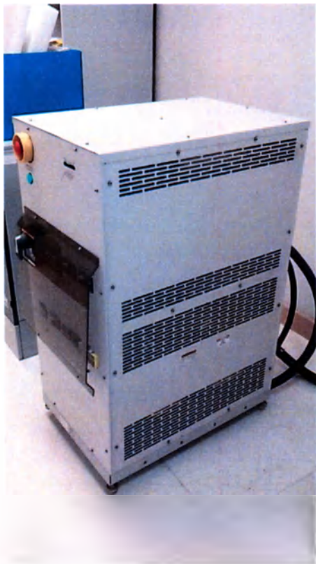
Рисунок 37. Силовой распределительный шкаф.
