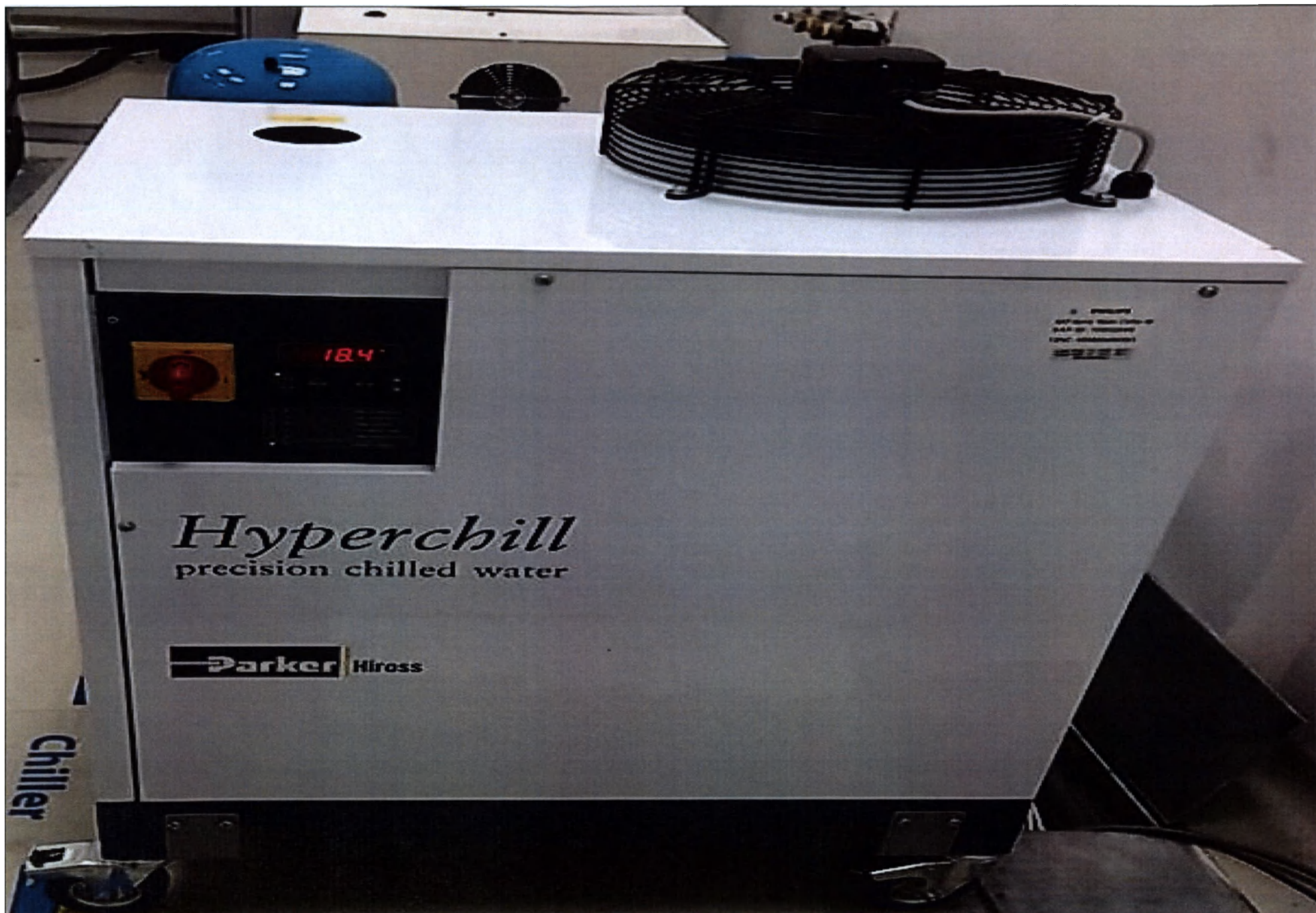
14б. Система охлаждения.
