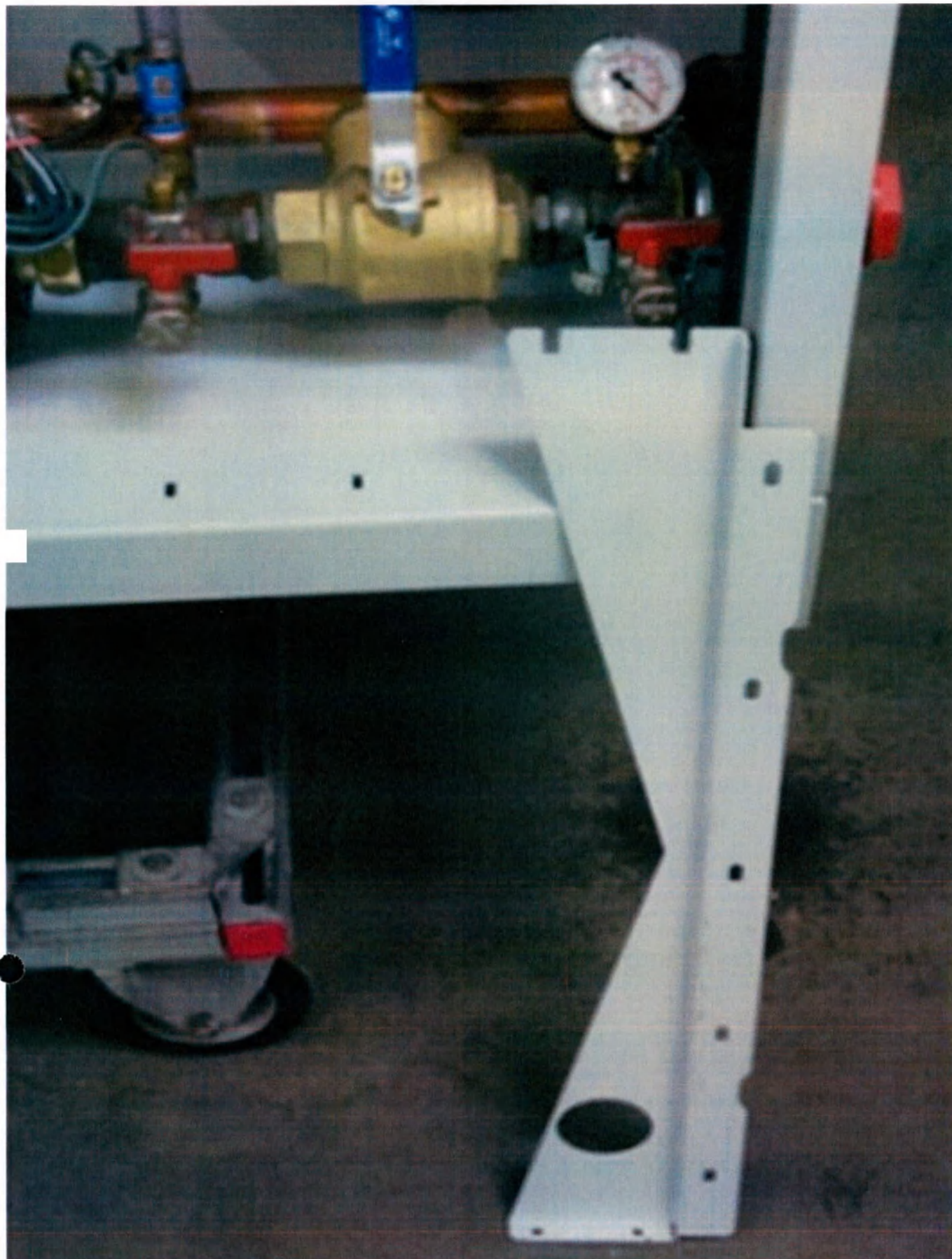
79.1 Монтажные фиксаторы для сейсмоопасных зон
