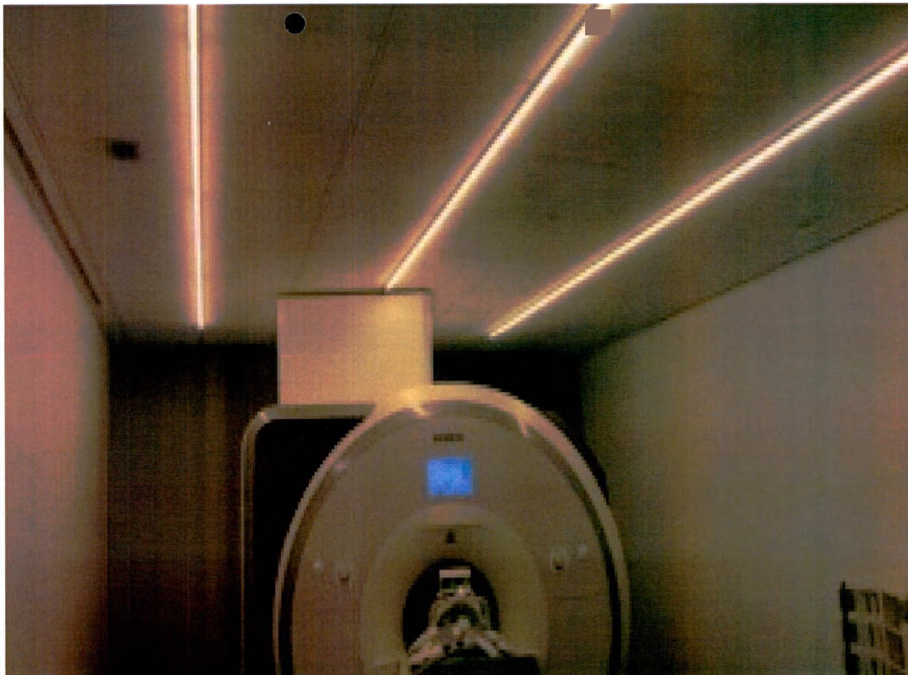
54. Облицовка радиочастотной кабины.
