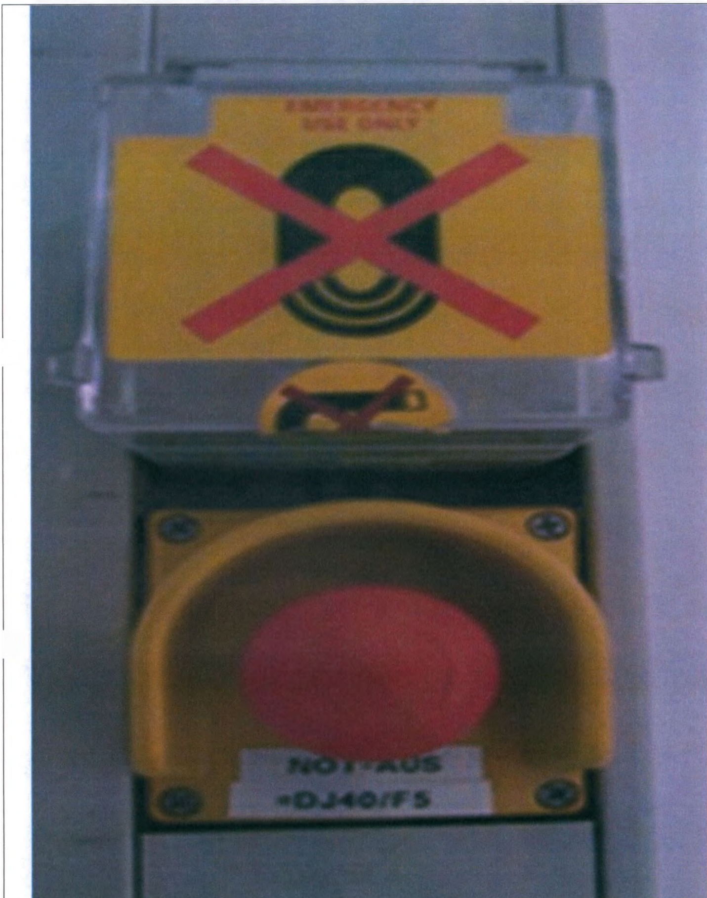
182. Выключатель аварийный.
