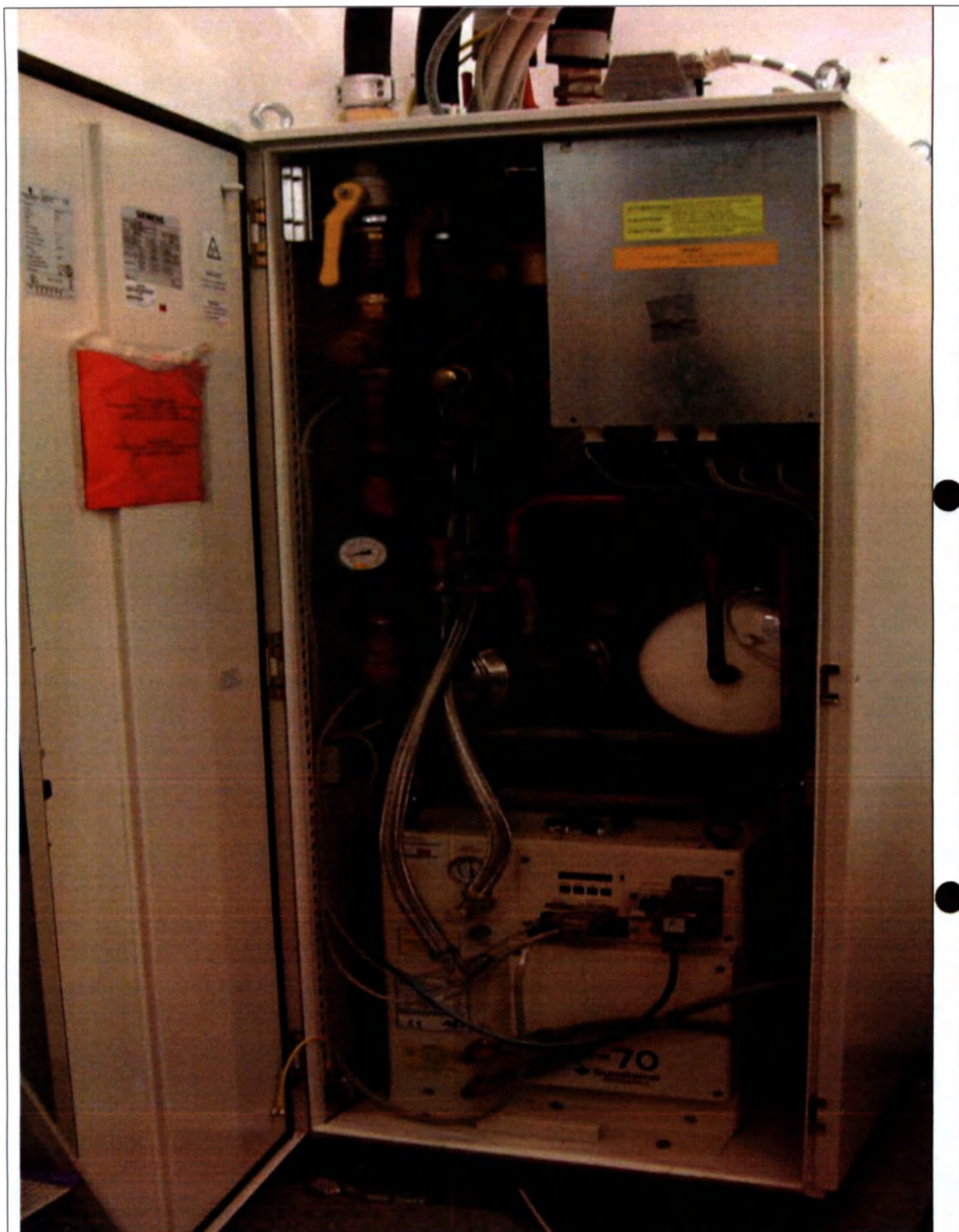
6. Система водяного охлаждения градиентных катушек и градиентных усилителей.
