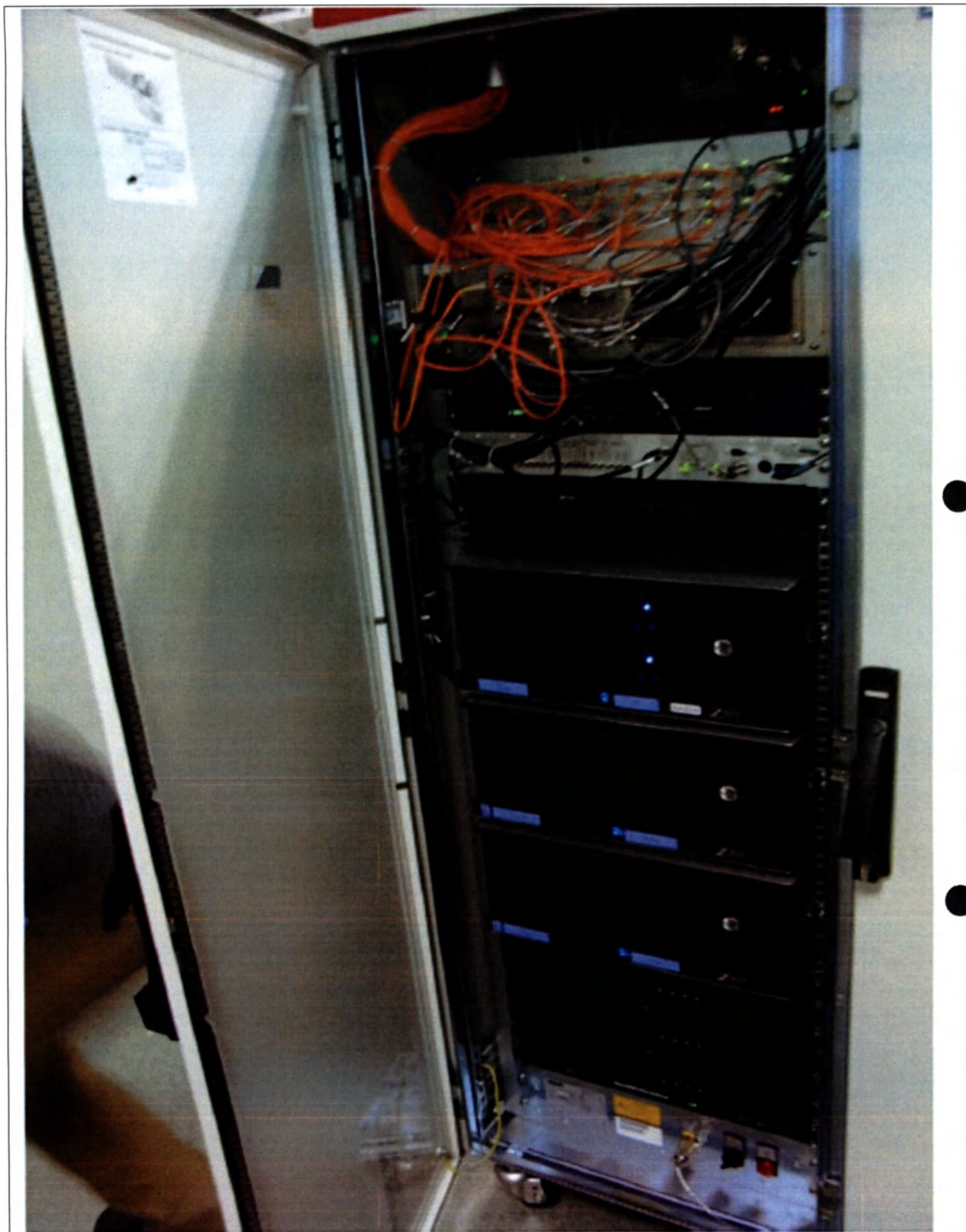
9. Шкафы электроники для управления системами сбора данных томографа.
