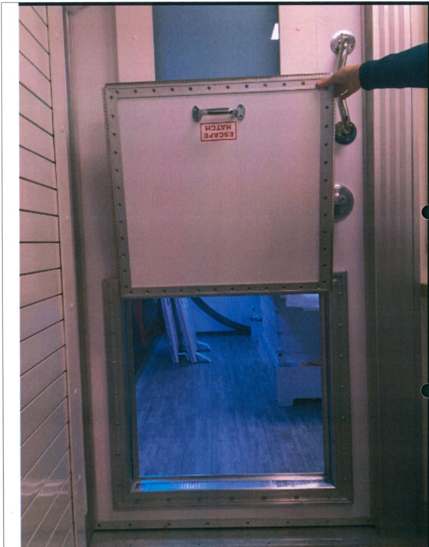
173. Люк аварийный для экстренной эвакуации.
