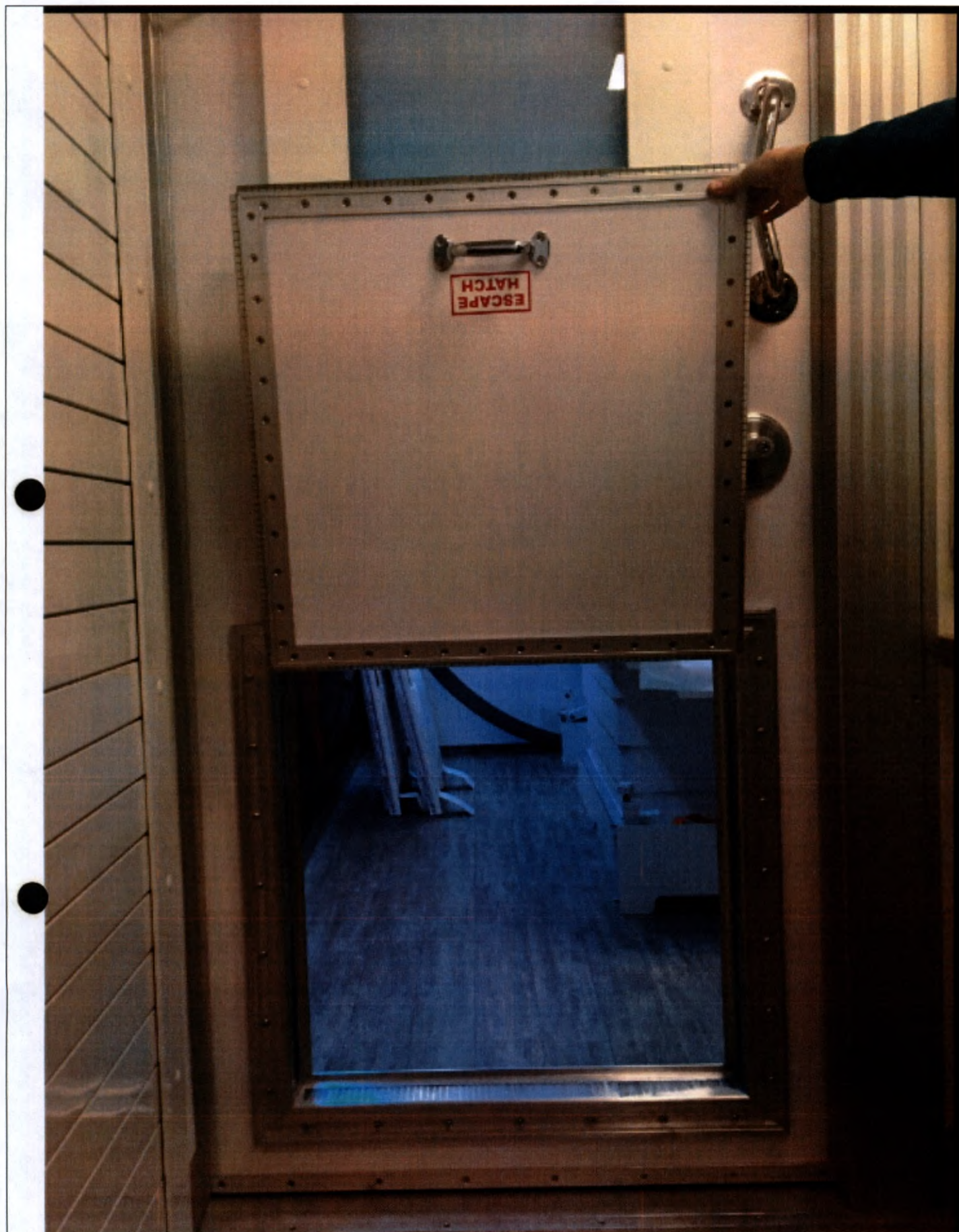
170. Люк аварийный для экстренной эвакуации.
