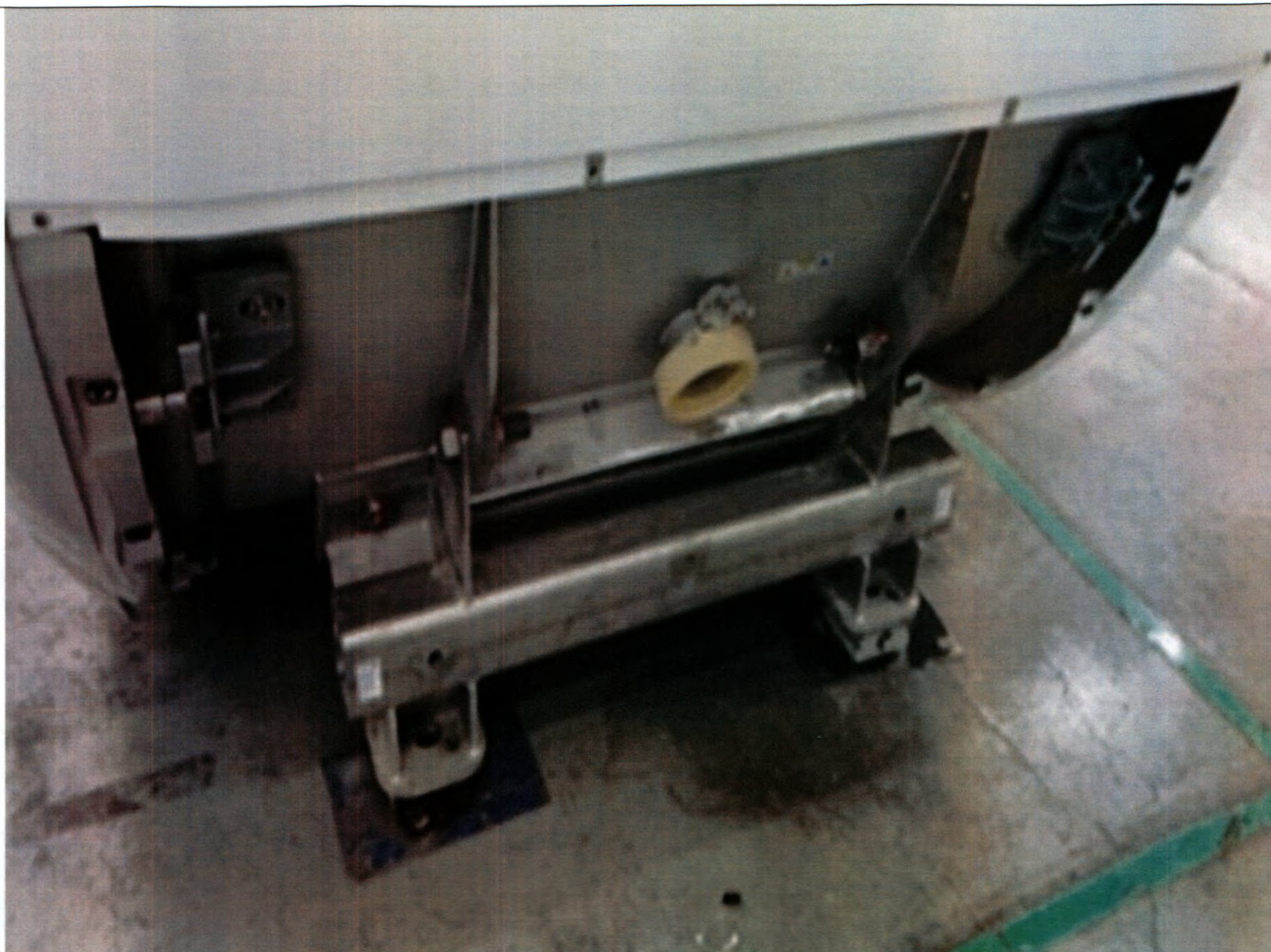
198. Специальный комплект для монтажа в сейсмоактивной зоне.
