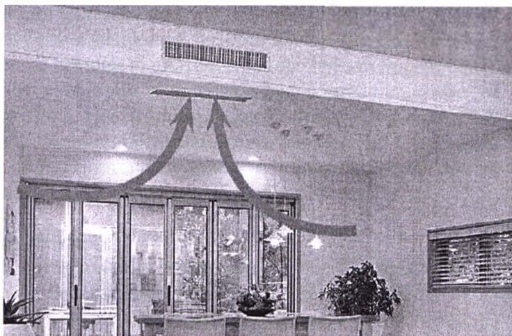
Рисунок 3 – Пример размещения устройства обеззараживания UV-JET
