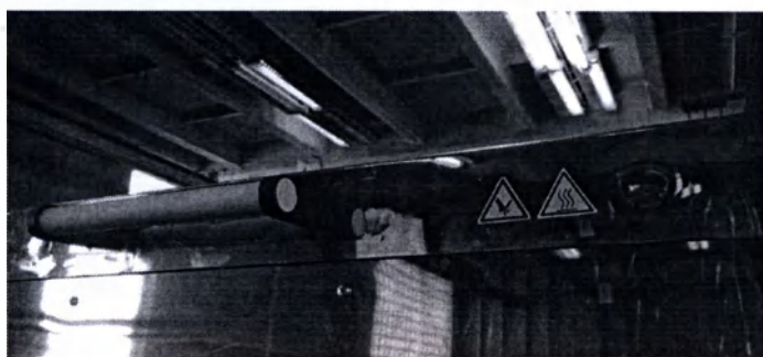
Рисунок 2 – Знаки угрозы заземления и опасности нагрева поверхности на крышке бака.
