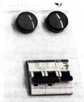
Рис. 41. Сигнальные лампы на распределительном коробе № 1.
