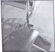
Наложить запаиватель на трубку и произвести пайку
