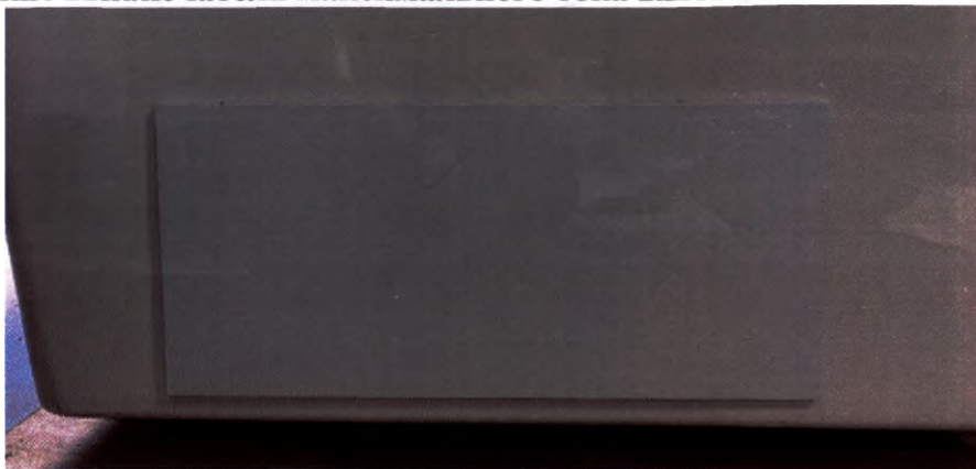
Рис. 8. Крышка на липучках для доступа к автоматам
