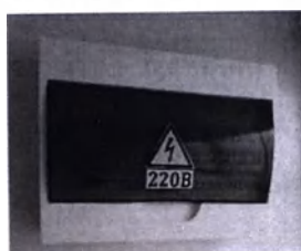
Рисунок 3. Навесной электрический распределительный щит.
