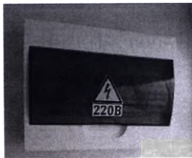
Рисунок 3. Навесной электрический распределительный щит.
